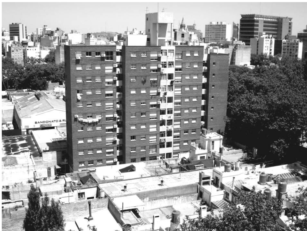
Figura 31: Edificio Copeclub CEA III
