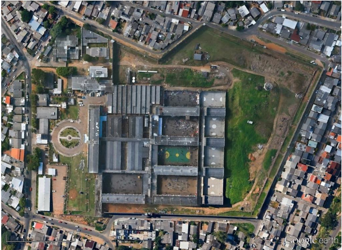
Figura 1 - Visão aérea do Presídio Central de Porto Alegre e imediações. Fonte: Google Earth. 2
