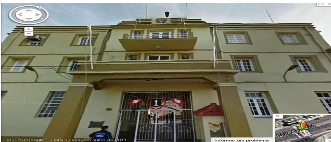
Figura 9 - Fachada da Escola de Formação de Praças de Santa Maria
