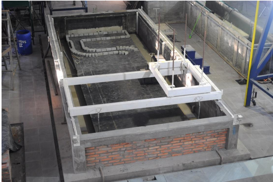
Figura 04 – Fotografia no início da construção do canal meândrico, posicionado dentro do tanque. Autoria: Autor, 2012.
