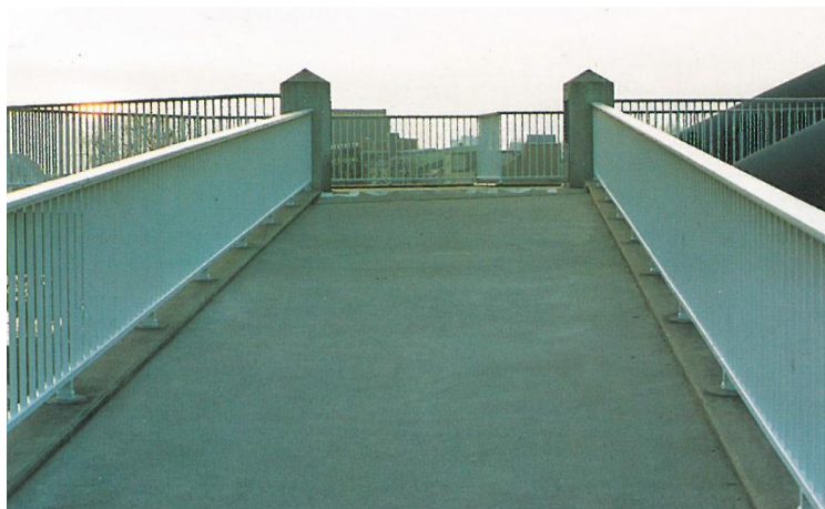
Figura 10 – Guarda-corpo com barras verticais
