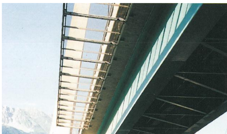
Figura 11 – Guarda-corpo com proteção sobre a rodovia
