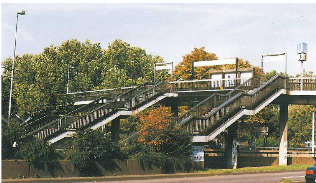
Figura 4 – Escadas para acesso de passarela
