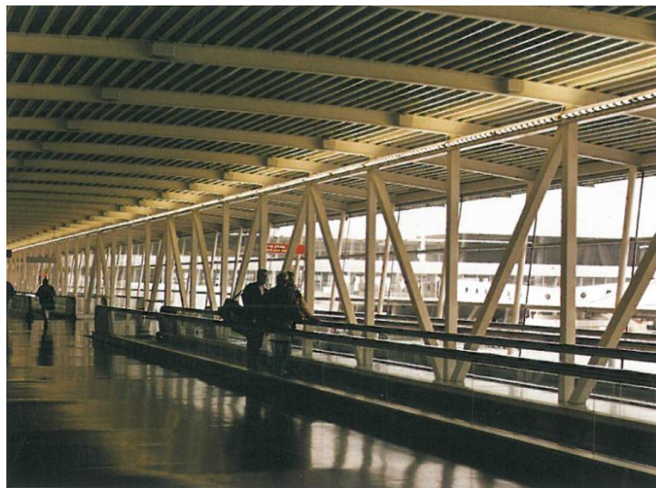
Figura 12 – Passarela com treliçados em aço
