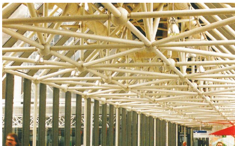
Figura 13 – Trelizado superior de uma passarela
