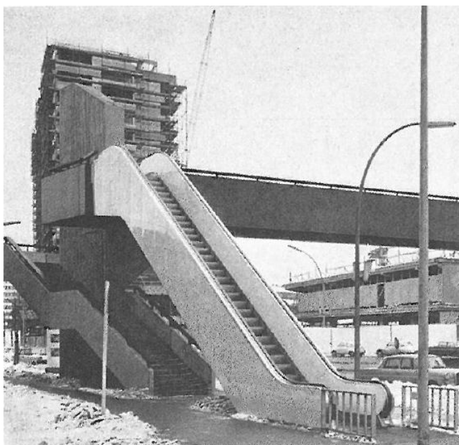
Figura 5 – Escada rolante para acesso de passarela
