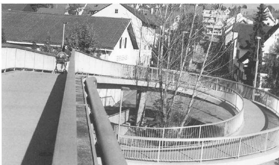
Figura 6 – Rampa para acesso de passarela
