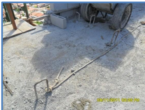
Figura 25: Levantamento de alvenaria: uso de caranguejo para amarração da linha de vida
