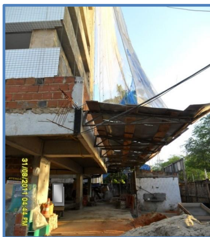
Figura 27: Revestimento externo: retirada precoce da plataforma principal
