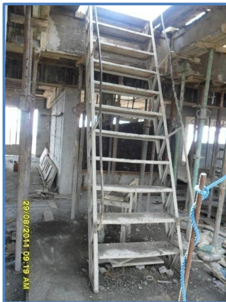
Figura 10: Escada provisória de acesso à laje a ser concretada
