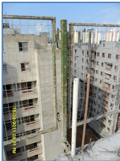
Figura 31: Laje concretada: rodapé do SGCR inadequado
