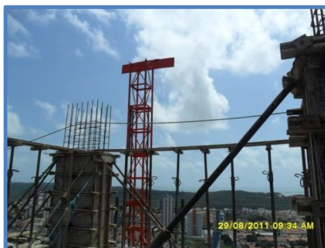
Figura 22: Confeção da forma: linha de vida amarrada nas ferragens do pilar
