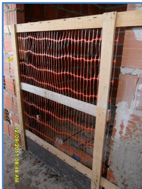
Figura 34: Poço do elevador: SGCR apoiado no sentido contra fluxo e uso de assoalho a cada 02 lajes
