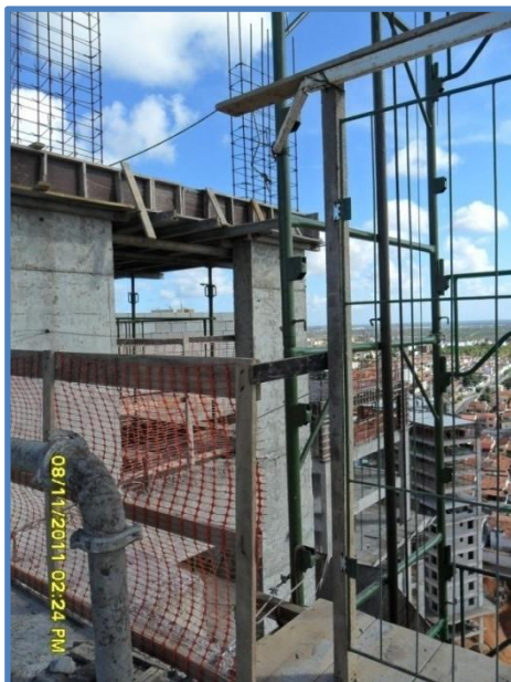
Figura 40: Rampa do elevador a cabo: sem SGCR
