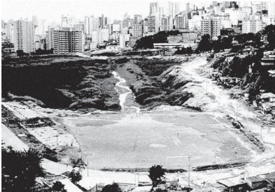
Figura 2 – Bacia de detenção sem benfeitorias
