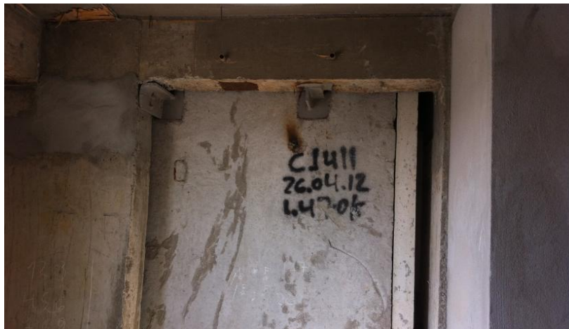
Figura 9 – Identificação do painel com letras e números
