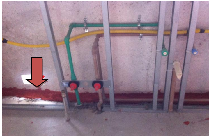
Figura 21 – Isolamento entre pavimentos
