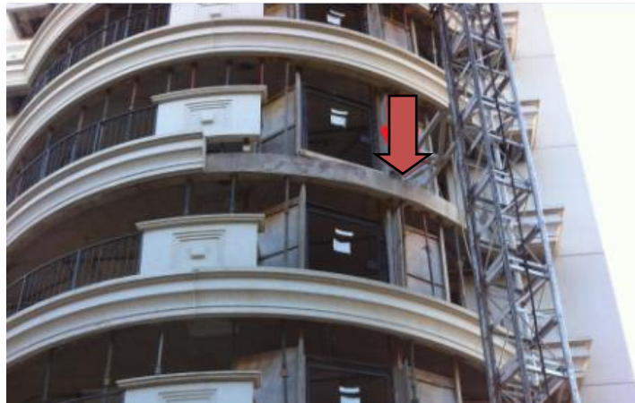
Figura 23 – Fixação do elevador cremalheira à estrutura
