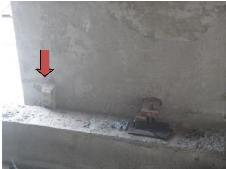
Figura 15 – Cunha de madeira para afastamento do painel
