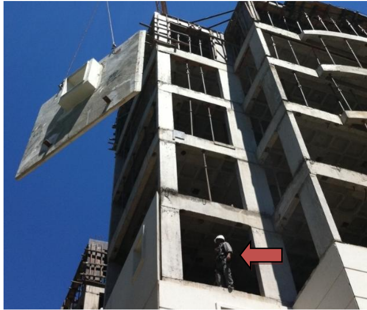
Figura 13 – Funcionário responsável por posicionar o painel
