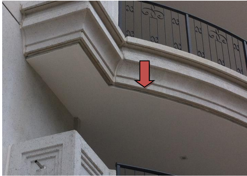
Figura 24 – Solidarização painel e forro de gesso
