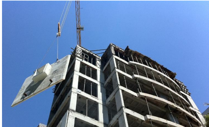
Figura 11 – Içamento dos painéis com grua
