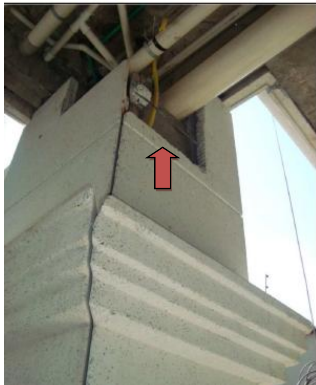
Figura 25 – Furações realizadas após a instalação dos painéis
