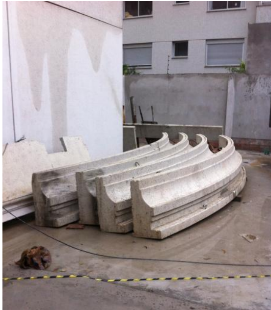
Figura 12 – Armazenamento dos painéis em canteiro de obras
