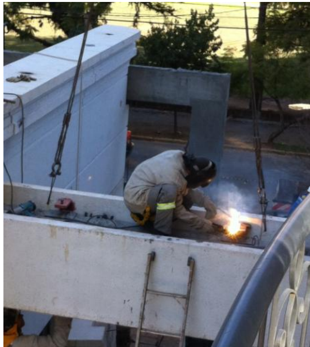
Figura 16 – Soldagem dos elementos de fixação
