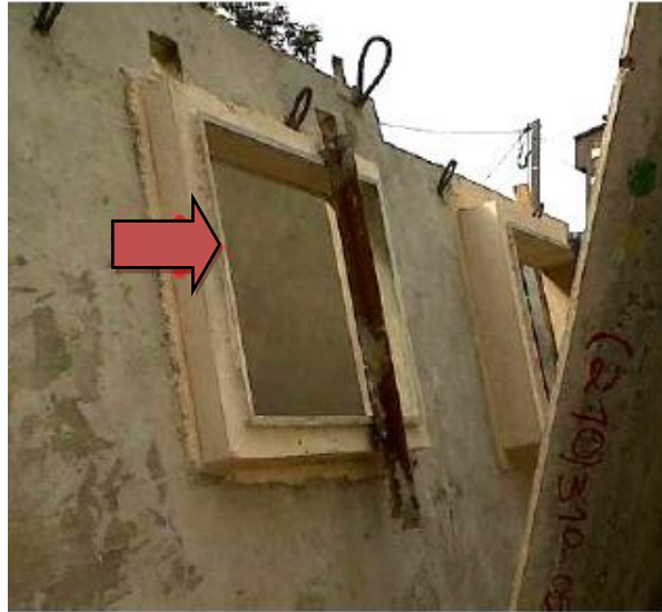
Figura 17 – Contramarcos instalados nos painéis
