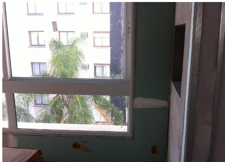
Figura 18 – Revestimento interno em Drywall
