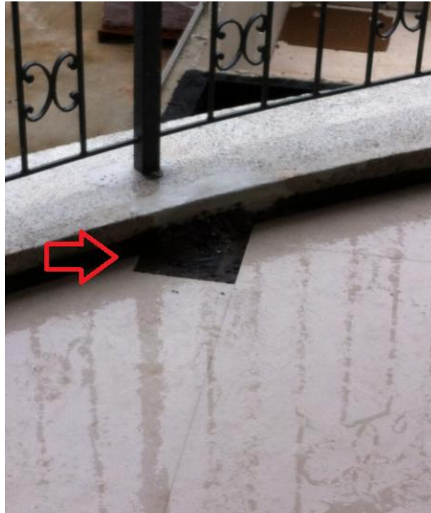
Figura 26 – Inserts acima do nível do piso acabado
