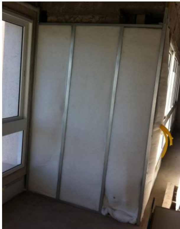
Figura 20 – Isolamento acústico das paredes
