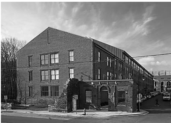
Figura 9: Fábrica convertida em condomínio de uso misto. Fonte: http://www.cbhassociates.com/projects/archive/residential/developer/millrace.htm
