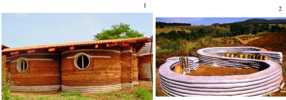
Figura 4: Superadobe 1. protótipo de residência construída com superadobe 2. plasticidade propiciada pela flexibilidade do material
