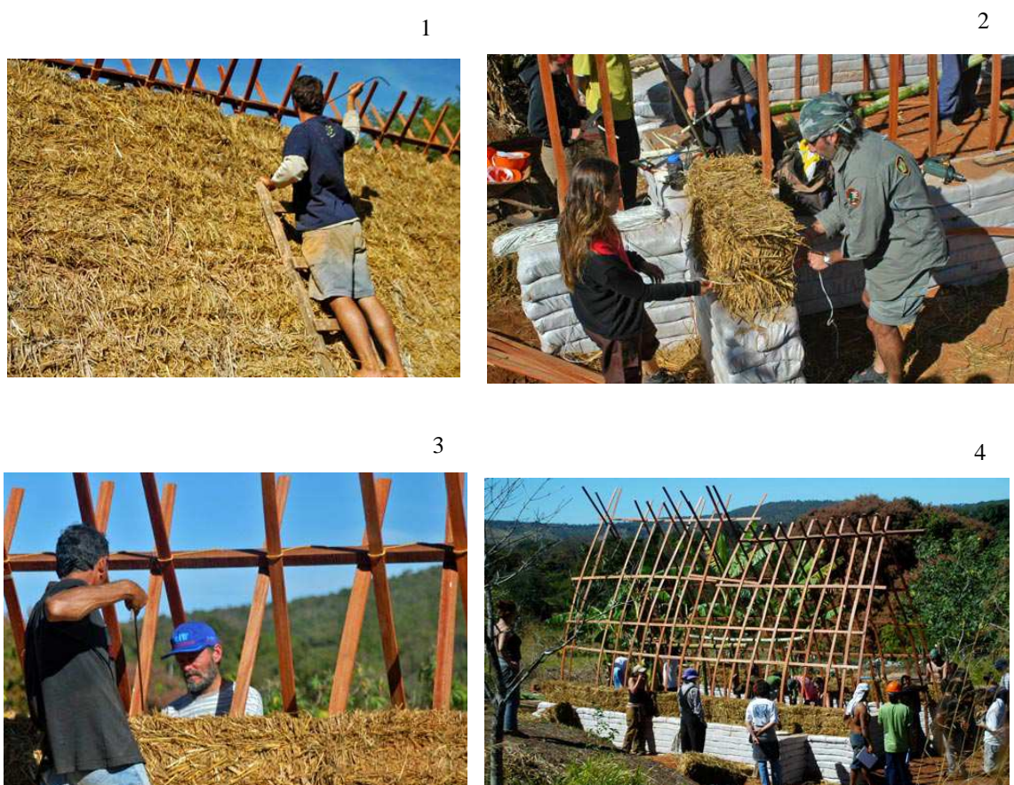
Figura 6: Construção com fardos de palha 1-2-3-4. Diferentes etapas da construção com fardos de palha
