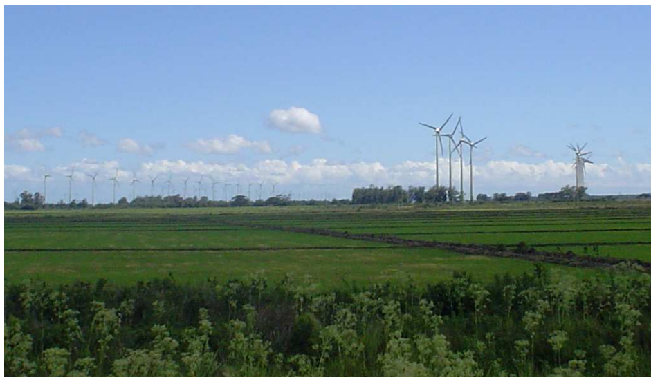
Figura 3 - Turbinas eólicas (aerogeradores), Parque eólico de Osório, RS
