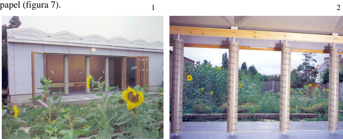
Figura 7: Construção com painéis e pilares de papel reciclado
