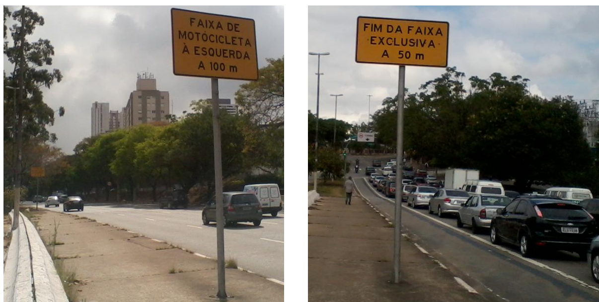
Figura 53: Sinalização vertical advertindo o início e o término da motofaixa Fonte: fotografia tirada in loco pelo autor
