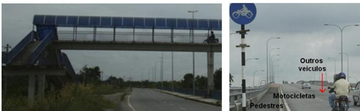
Figura 44: Viaduto para motocicletas e ponte com faixa segregada
