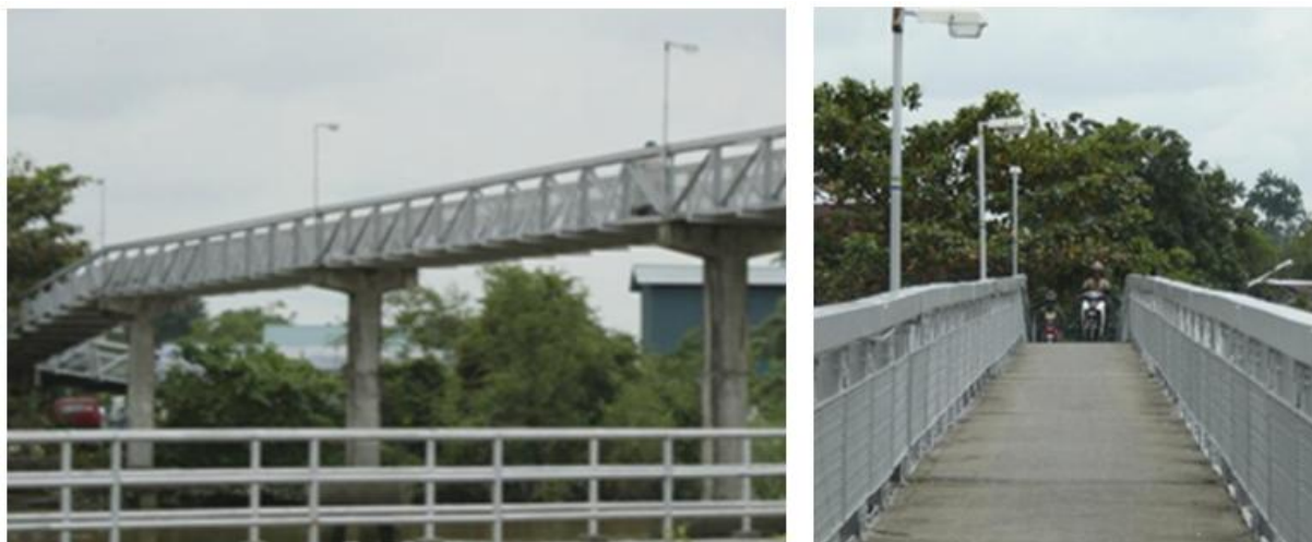
Figura 43: Ponte dedicada ao uso de motocicletas
