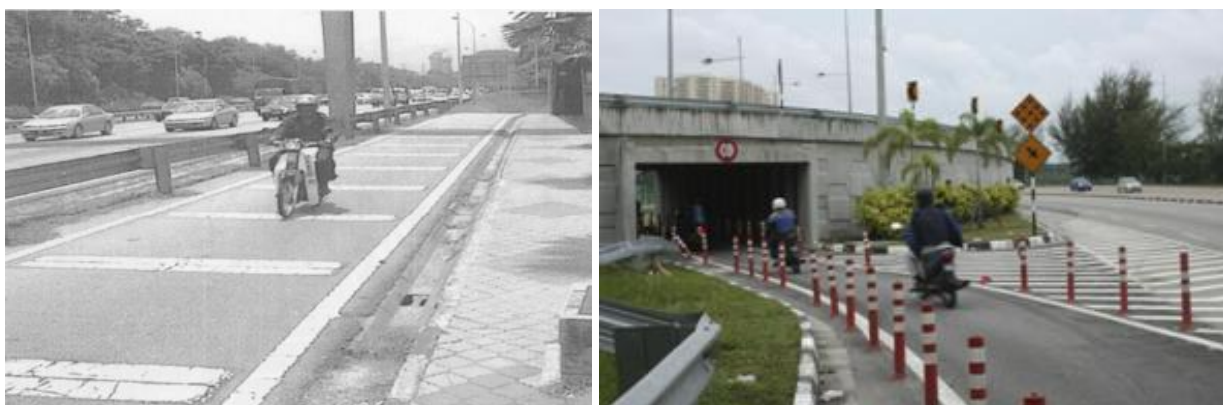
Figura 50: Faixa exclusiva para motocicletas na Malásia Fonte: Sohadi e Law (2005) e Briggs (2008)
