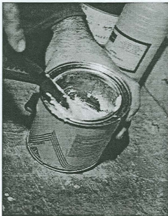
Figura 19 – Mistura dos componentes da resina epóxi.
