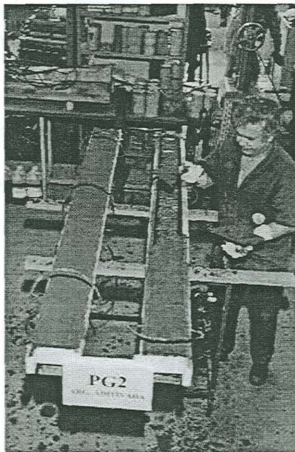
Figura 15 – Execução dos reforços com argamassa com adição de sílica ativa.
