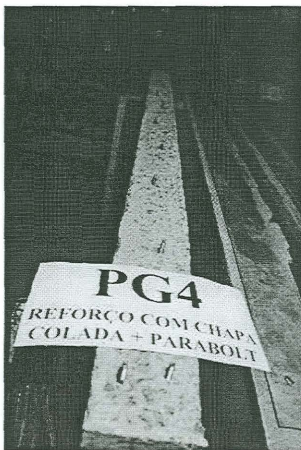
Figura 16 – Posicionamento dos parafusos auto-fixantes.
