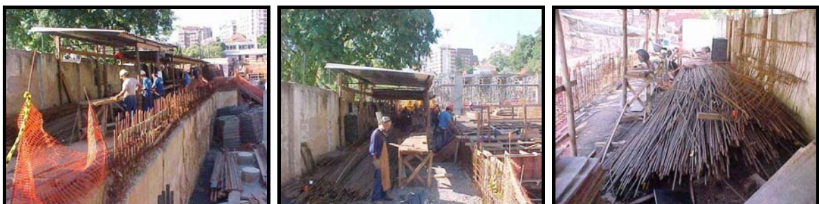
Figura 32: Local em que ocorreram paralisações da produção visto a necessidade de se utilizar esta área como acesso.
