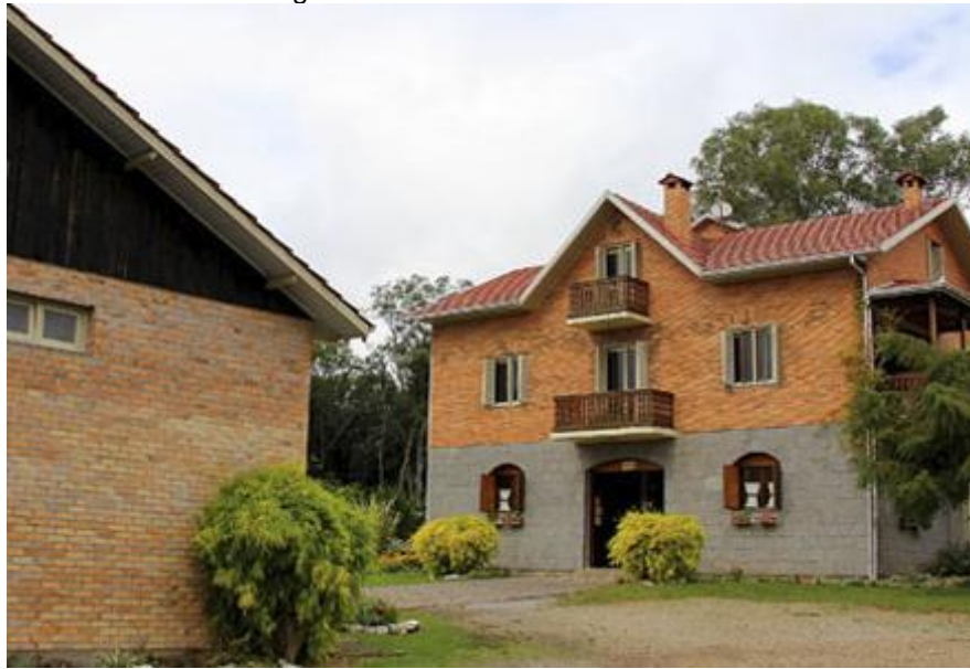
Figura 8 – Prédio da Casa do Tomate
