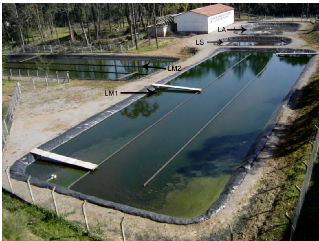
Figura 4: Imagem das Lagoas de Estabilização da ETE-UCS, Caxias do Sul, mostrando: (LA= Lagoa Aerada; LS= Lagoa de Sedimentação; LM1= Lagoa de Maturação 1; LM2= Lagoa de maturação 2 (fonte: ISAM-UCS).
