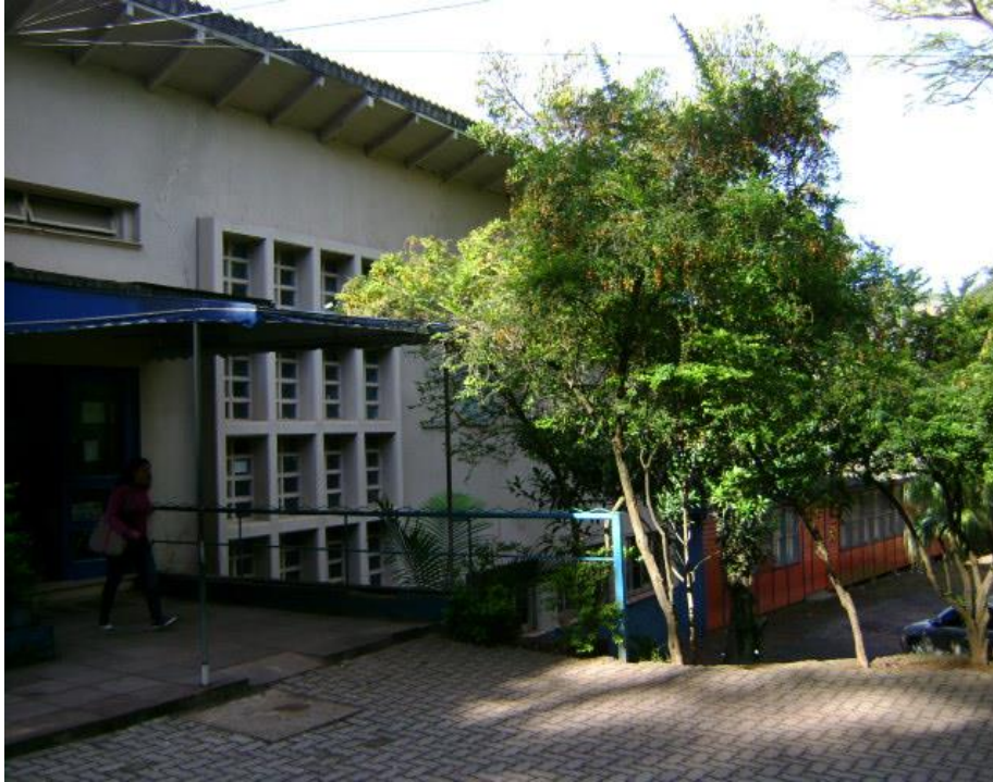
Figura 4 6 : Fachada do Prédio Administrativo.
