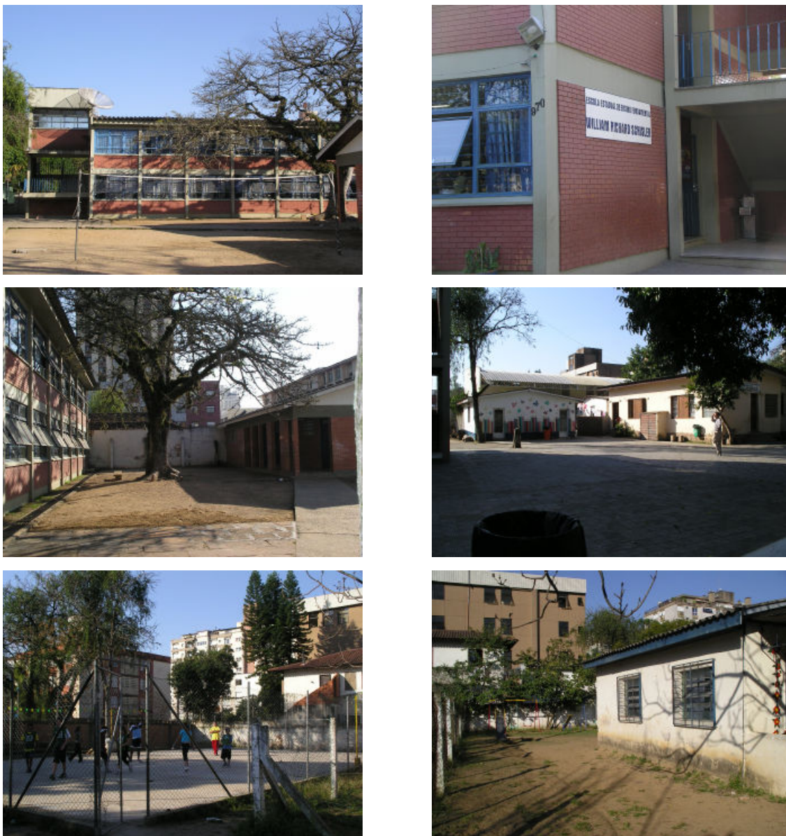
Figura 65: Escola William R. Schisler: prédio principal, anexos e espaços externos
