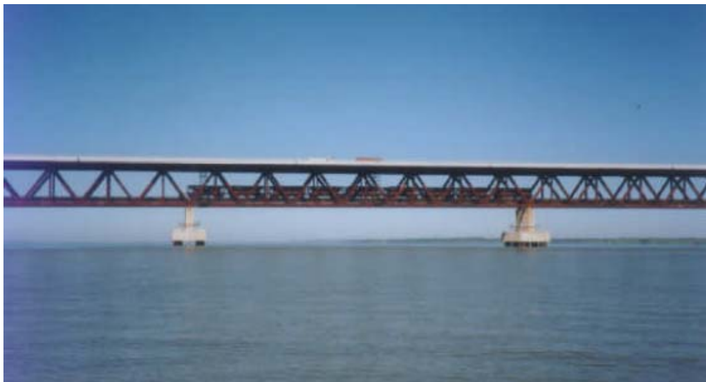
Figura 3.7: Ponte Rodoferroviária sobre o Rio Paraná
