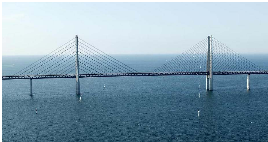
Figura 3.2: Vão principal da Ponte Oresund
