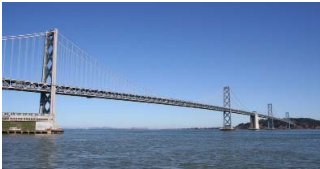
Figura 3.1: Vão oeste da San Francisco–Oakland Bay Bridge
