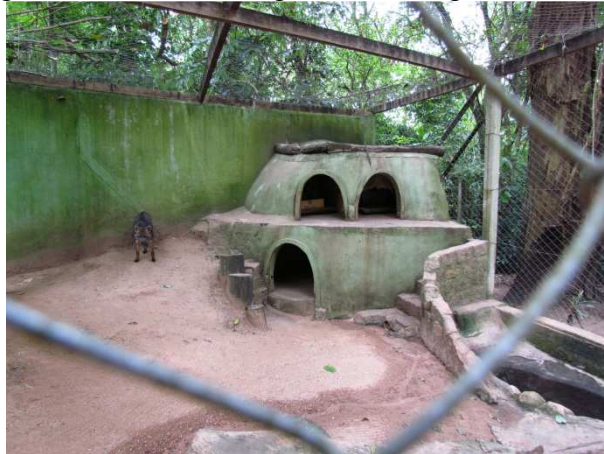
Figura 2 – Recinto dos graxains Abrigo de alvenaria
