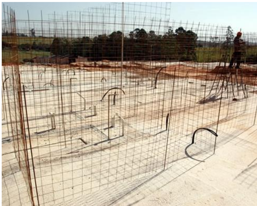
Figura 3 – Armaduras posicionadas conforme projeto
