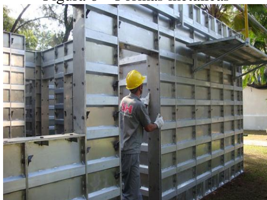
Figura 6 – Fôrmas metálicas
