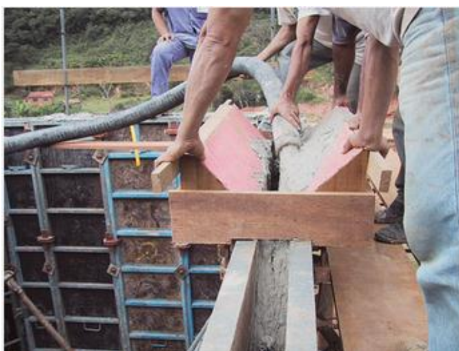
Figura 8 – Aplicação do concreto
