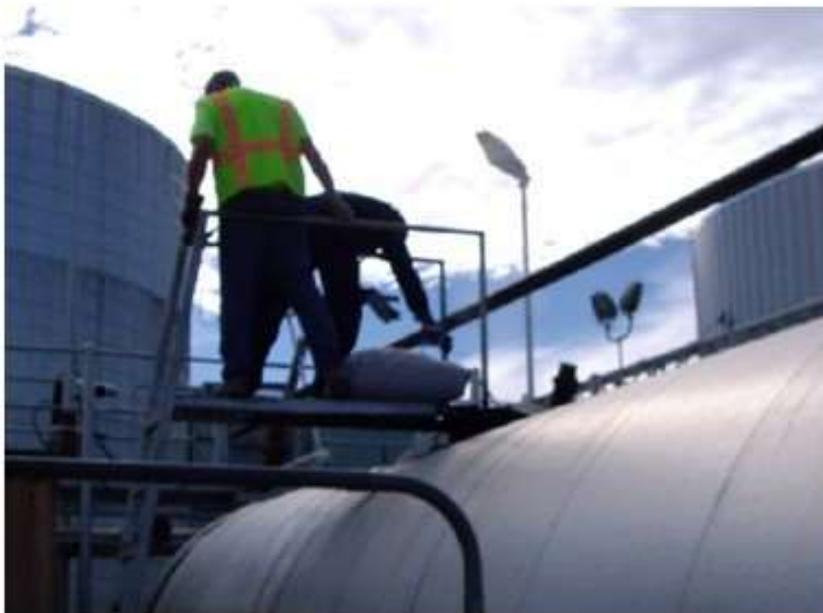
Figura 2.43–Inserção de pastilhas de Rediset<sup>®</sup> no tanque de CAP
