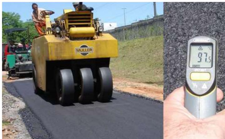
Figura 5.37 - Final da compactação da mistura morna na primeira camada (97,5°C)
