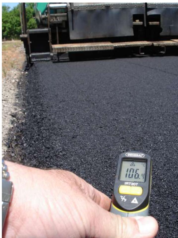
Figura 5.38 - Espalhamento da segunda camada (106°C)
