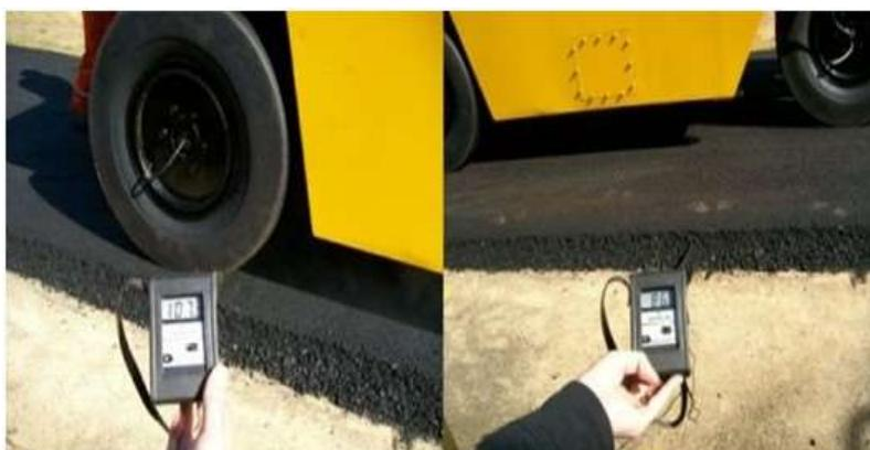
Figura 5.22 - Início e final da compactação da mistura morna com rolo de pneus (107,3°C e 86,8°C)
