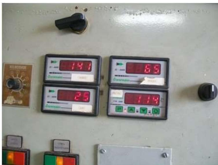
Figura 5.5 – Controle de temperatura da mistura através da temperatura do filtro de manga
