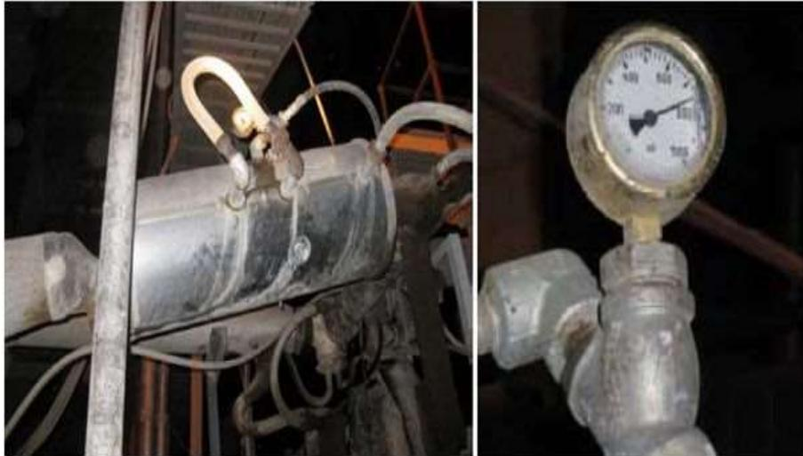
Figura 2.14—Câmara de mistura e injeção sob pressão do sistema AQUABlack<sup>®</sup>
