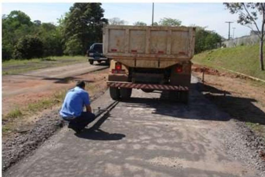
Figura 3.24 - Pista 2 – Controle estrutural da base através da viga Benkelman na base
