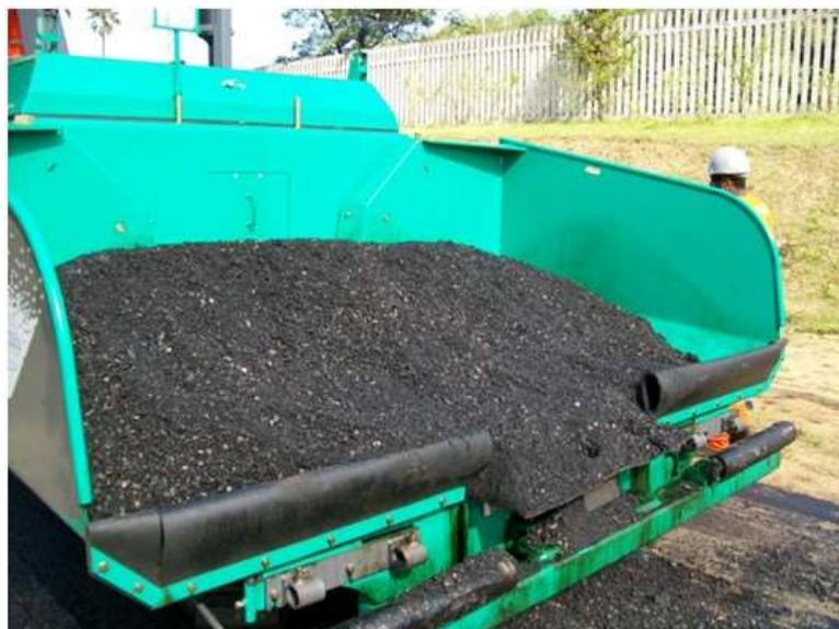
Figura 5.17 – Mistura morna com deficiência de recobrimento
