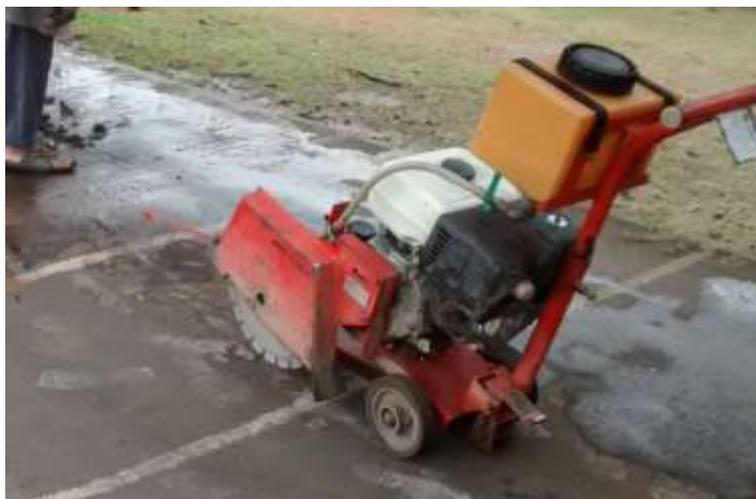
Figura 4.19 – Retirada de placa de asfalto da pista 2
