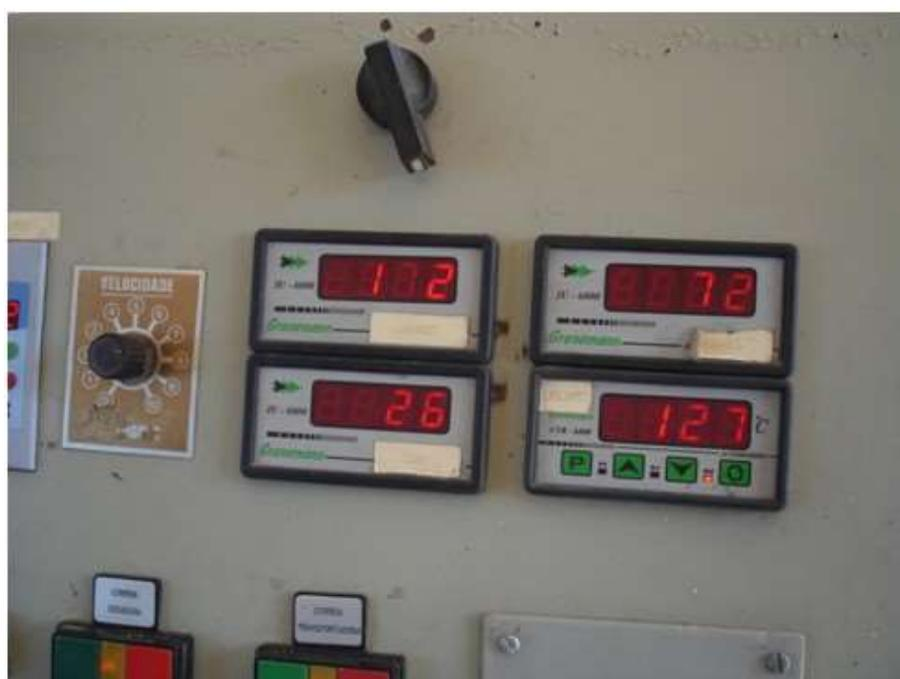
Figura 5.10 – Controle da temperatura no filtro de manga (127°C)
