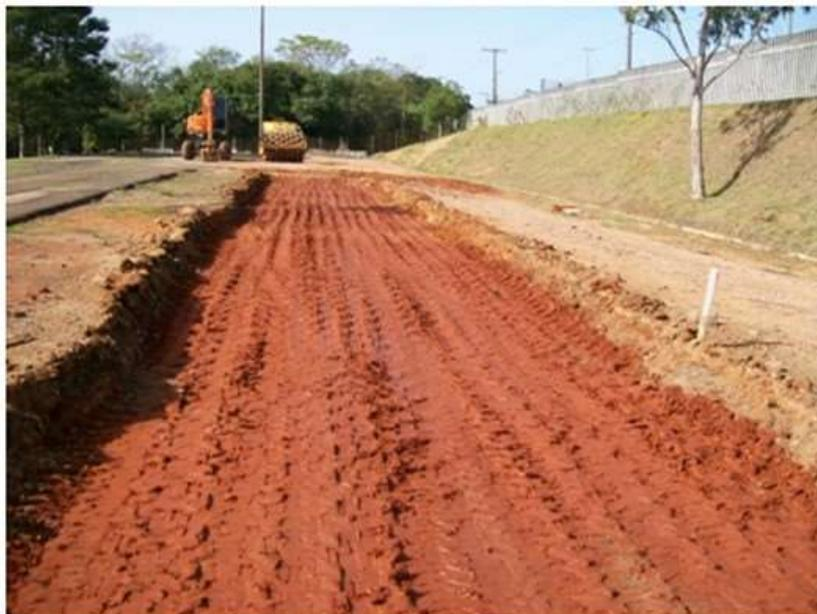
Figura 5.26 - Pista 2 – Compactação do subleito argiloso.
