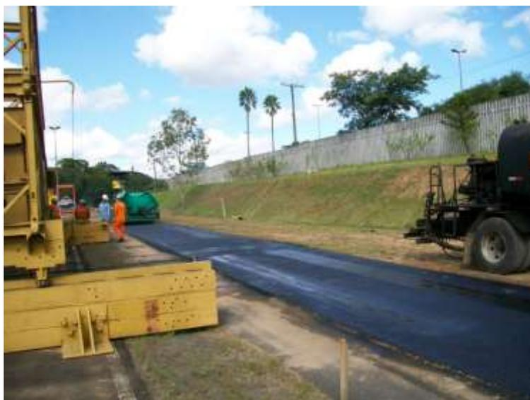
Figura 5.19 – Imprimação da pista existente
