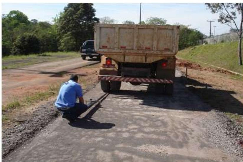
Figura 5.30 – Verificação da base de brita graduada através da viga benkelman
