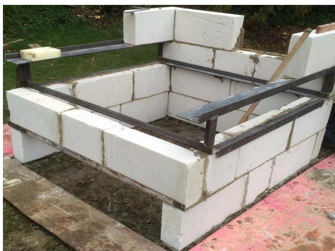
Figura 4 – Detalhe da estrutura metálica do simulador de incêndio
