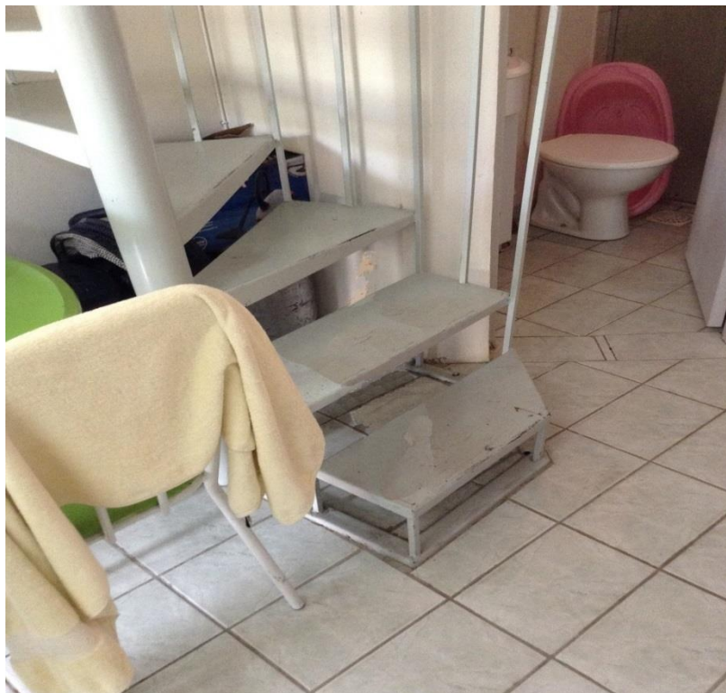
Figura 15 – Falta de acessibilidade entre os dois pavimentos
