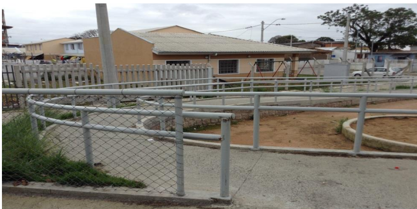
Figura 16 – Rampa com inclinação suave no condomínio estudado
