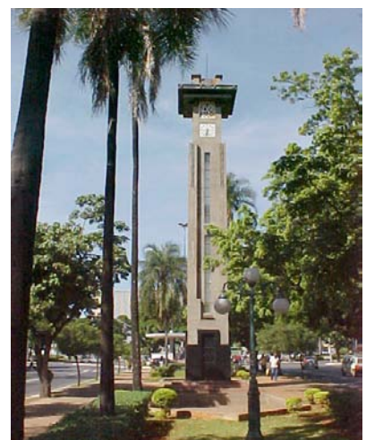
Figura 152: A revitalização do Relógio.
