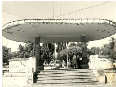
Figura 145. Coreto, junto à Praça Cívica e limite (sul) da Avenida Goiás.
