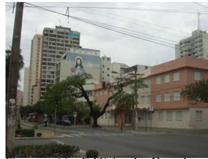
Figura 128. Edifício do Grande Hotel revitalizado (2002).
