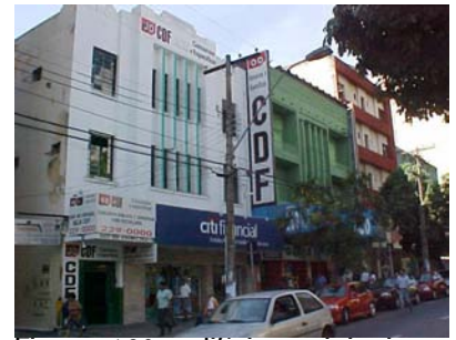
Figura 129: edifícios originais art déco com revitalização prevista no projeto Cara Limpa .
