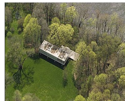
Figura 78: Casa Farmworth – Mies van der Röhe – valorização do edifício com o espaço verde.
