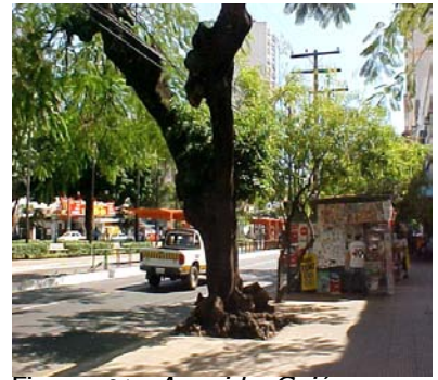
Figura 81: Avenida Goiás, Goiânia – conflito de espécie arbórea com rede elétrica e calçada.
