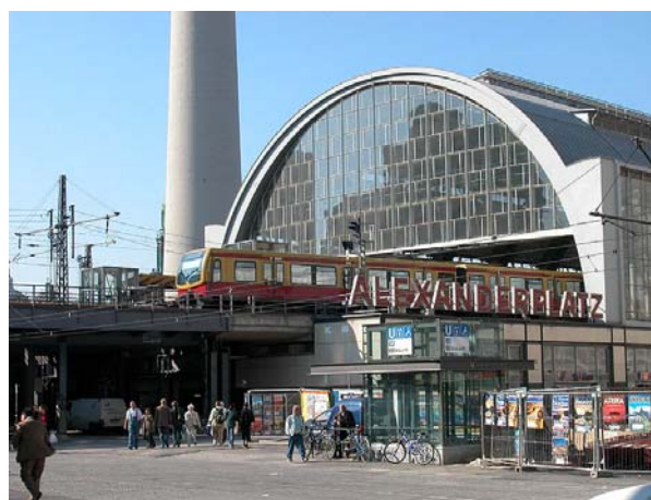
1962-1964 - Bahnhof e Bahnviadukt – estação e viaduto.
