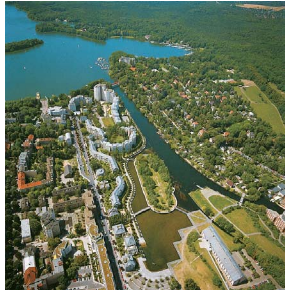
IBA-Berlin 87 - Tegel - Plano de Massas e Coordenação de projetos: Arq. Charles Moore. Fonte: www.archinform.net
