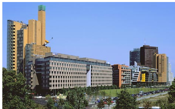
Debis-Areal – vista do parque. Fonte: www.dilysoftt.de
