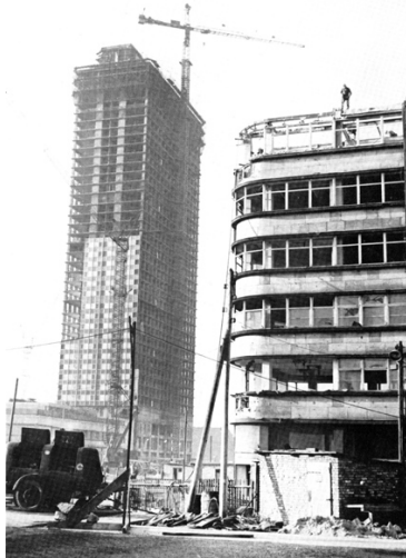
1967-1970 - Hotel Stadt Berlin em construção - 123 m de altura e 2.000 leitos.
