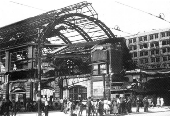
1945- Ruínas da Estação Ferroviária. Fonte: www.stadtentwicklung.berlin.de
