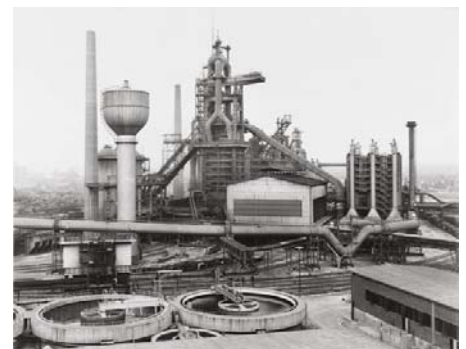
Bernd y Hilla Becher Gutehoffnungshütte West, Oberhausen, 1963
