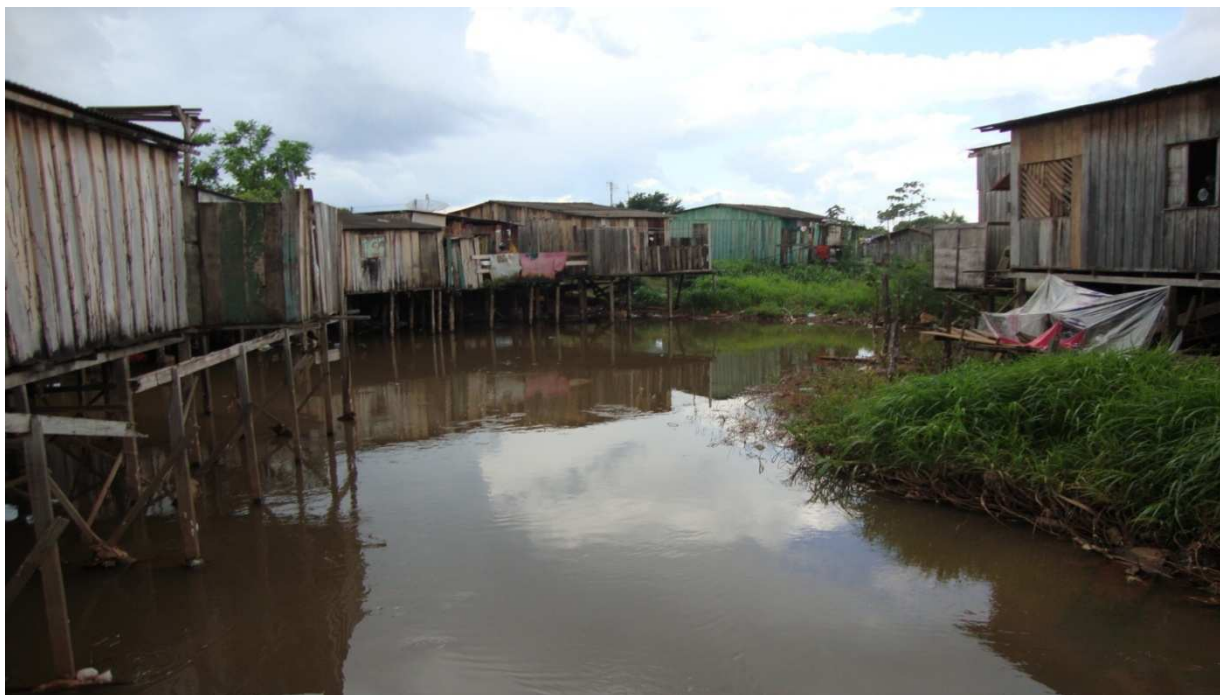
Figura 13: Palafitas sobre o Igarapé Altamira, área que está sendo desapropriada pela Norte Energia, julho/2014.
