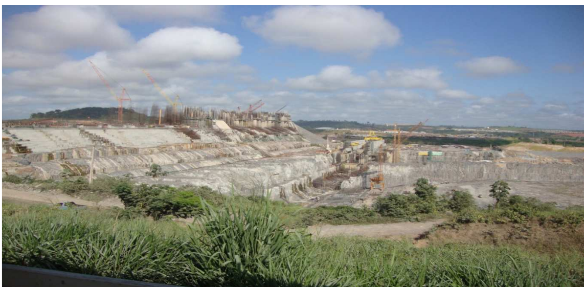
Figura 12: Usina Hidrelétrica, em construção, no Sítio Belo Monte (usina principal), Vitória do Xingu, julho/2014.
