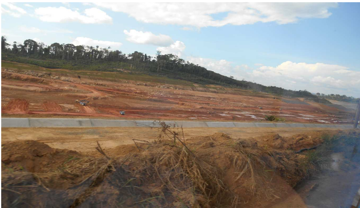
Figura 11: Canal de derivação em construção em Vitória do Xingu, julho/2014.
