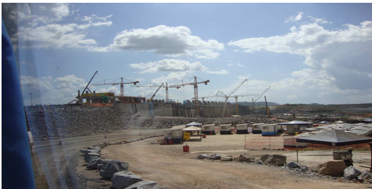
Figura 10: Usina Hidrelétrica, em construção, no Sítio Pimental (barragem principal e usina secundária), Altamira, julho/2014.
