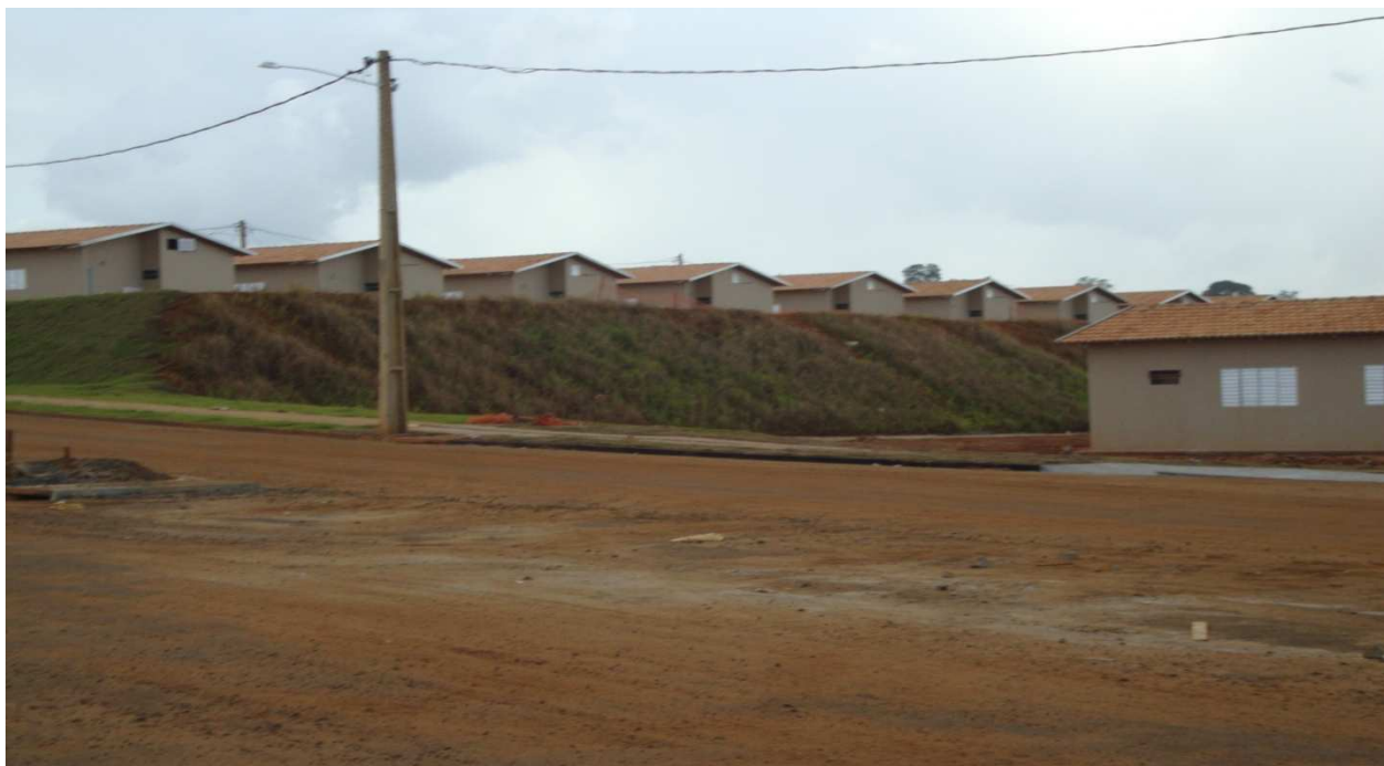
Figura 15: Reassentamento urbano no bairro Jatobá, Altamira, julho/2014.
