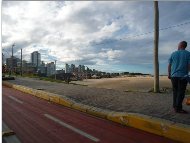
Foto 57: Verticalização ao longo da orla, com a retirada de dunas e a construção de infraestruturas de comércio, lazer e serviços para atendimento da população no município de Torres. Fonte: Aline Kunst, em 29/06/2014.
