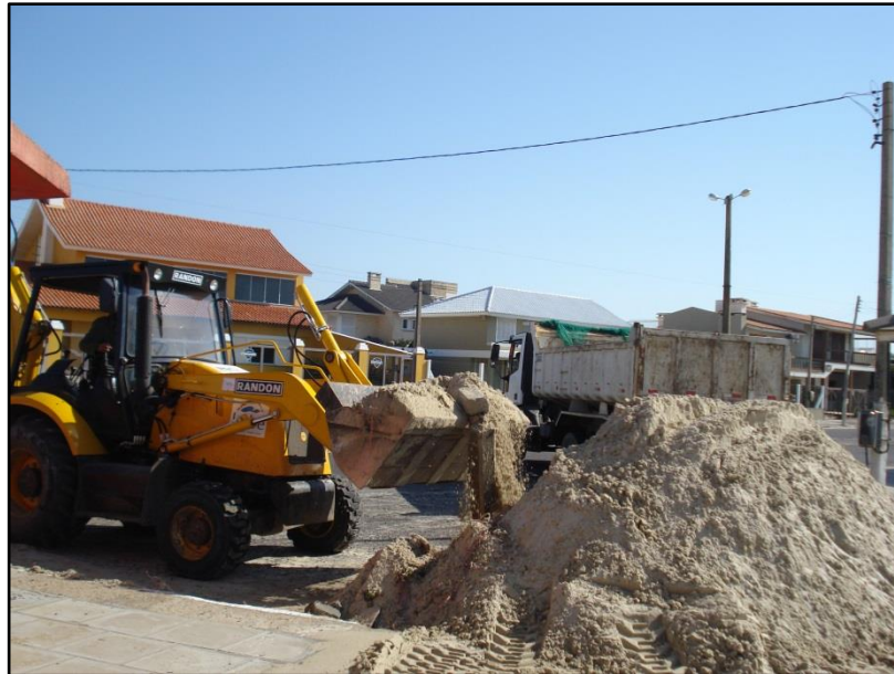
Foto 67: Remoção da areia que invade o calçadão, realizada pela Prefeitura Municipal de Imbé. Fonte: Aline Kunst, em 17/08/2013.
