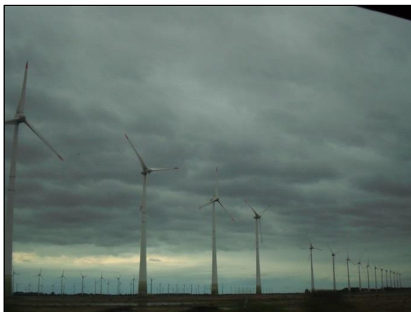
Foto 53: Aerogeradores vistos ao longo da rodovia, Planície Lagunar do município de Osório. Fonte: Aline Kunst, em 28/06/2014.
