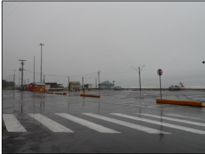
Foto 49: Substituição das dunas frontais por estruturas de atendimento aos veranistas junto à orla, Capão da Canoa. Fonte: Aline Kunst, em 28/06/2014.
