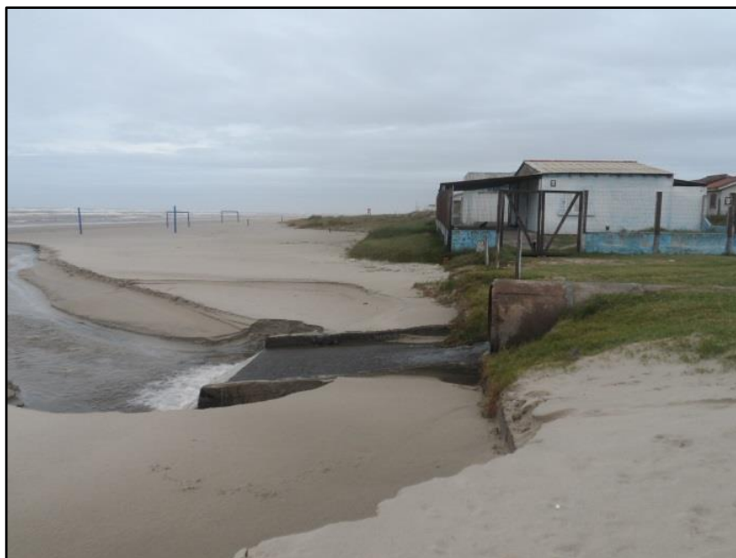
Foto 63: Construções irregulares sobre as dunas e efluentes líquidos lançado no mar sem tratamento, Balneário Pinhal. Fonte: Aline Kunst, em 28/06/2014.
