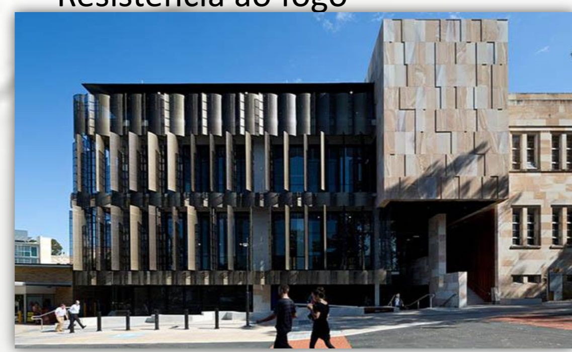
Fig. 4 – Edifício mais recente com geopolímero (Universidade de Queensland, Austrália)
