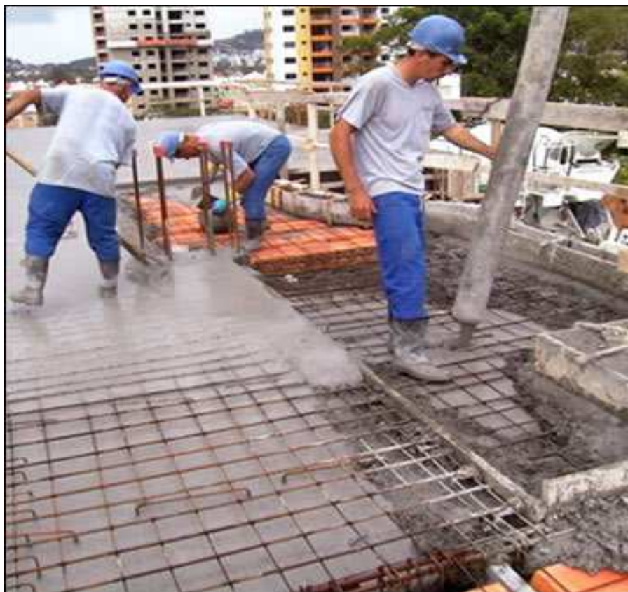
Figura 14: concretagem com CAA da laje tipo (Fonte: Repette, 2005b)
