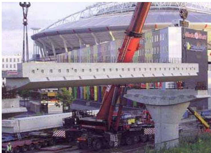
Figura 2: peça tabuleiro utilizada na estação de metrô do Amsterdã Arena (Fonte: Walraven, 2005)
