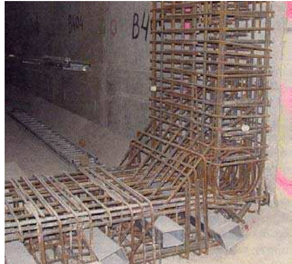
Figura 7: vista da armadura da estrutura (Fonte: Walraven, 2005)
