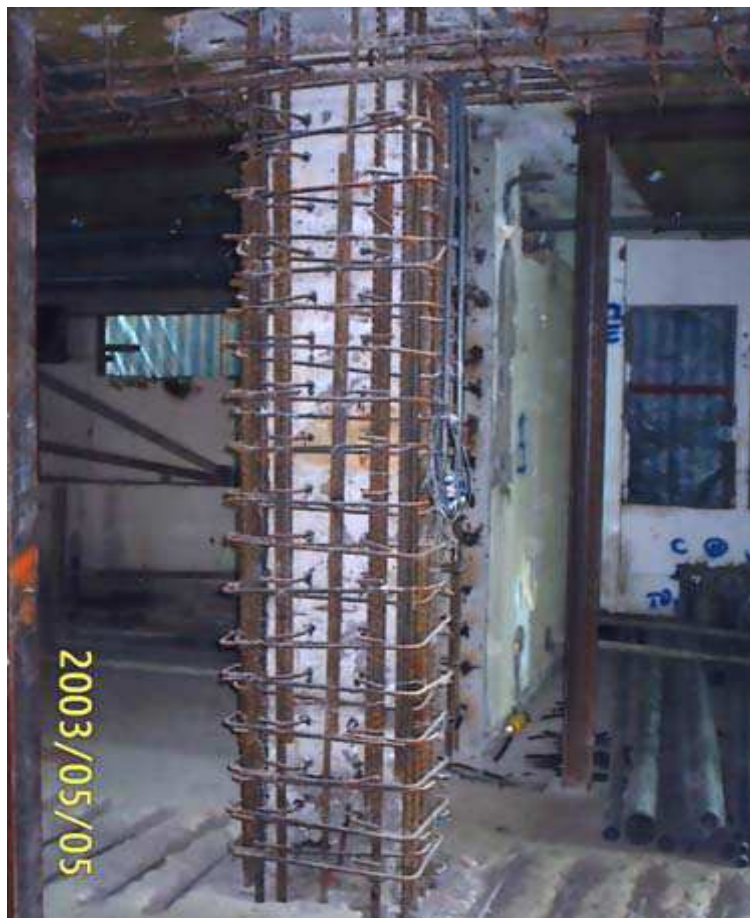
Figura 10: pilar sendo reforçado para concretagem com CAA (Fonte: Chai e Yang, 2005)
