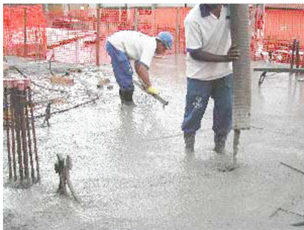
Figura 11: laje sendo concretada com o CAA com poucos trabalhadores (Fonte: Geyer, 2005)
