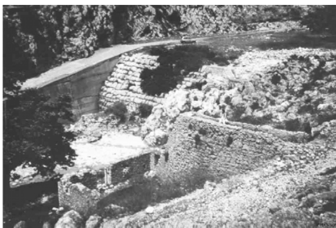
Figura 3.1 - Barragem na Arkananian, Grécia (1300 a.C.). (Fonte: Chanson, 2002).
