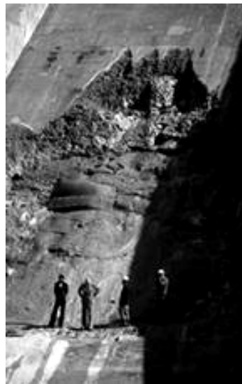
Figura 2.1 – Cavitação no vertedouros da Barragem de Karun – Irã (Fonte: http://www.vaw.ethz.ch , acesso 07/08/2006).
