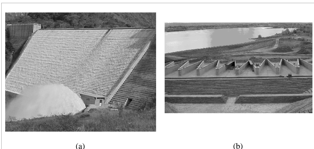
Figura 3.2 – (a) Barragem de São Bento – Casan – SC, Brasil. Alturas dos degraus de 0,60 m e do vertedouro 50 m. Cortesia da Magna Engenharia Ltda.; (b) reabilitação da Barragem de Standley Lake - Westminster, Colorado, EUA (Fonte: http://www.asircc.com/page3.html , acesso 07/08/2006).
