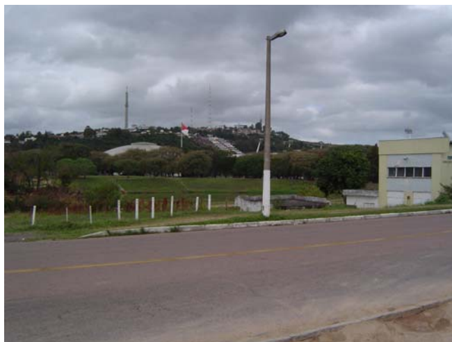
Figura 5.15. Casa de bombas, bacia de retenção e cabeceira da bacia hidrográfica (01/05/2004)
