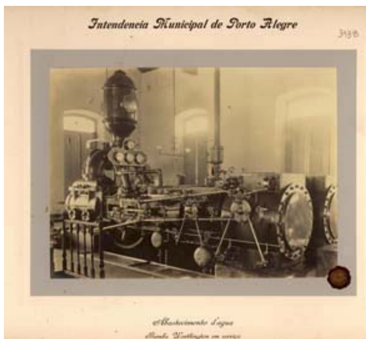
“Abastecimento d’Agua Bomba Worthington em serviço” Intendência Municipal de Porto Alegre “Vistas do Novo Abastecimento d’Água”
