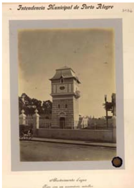
“Abastecimento d'Água Torre com reservatório metálico”
