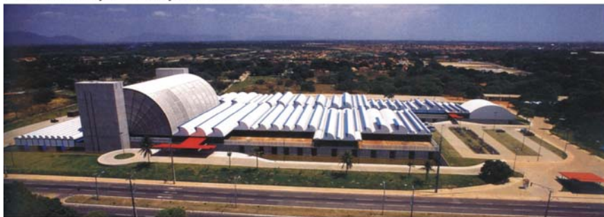
Fig.1.21 - vista aérea do hospital.
