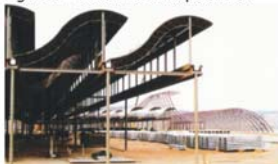
Fig.1.40 - montagem da estrutura.
