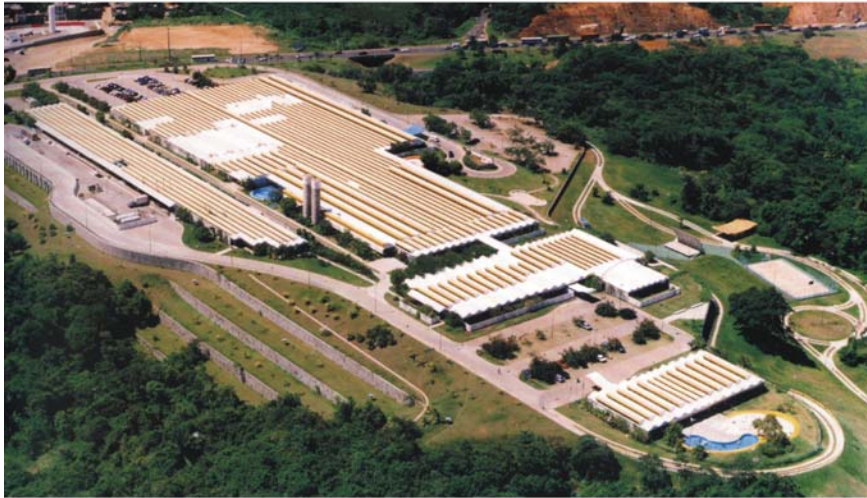
Fig.1.13 - vista aérea do hospital.
