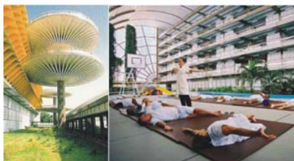
Fig.1.22 - solários e pátio coberto.
