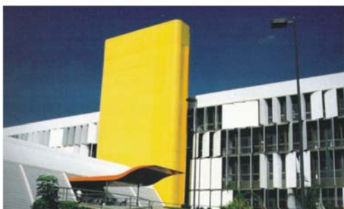
Fig.1.35 -acesso ao ambulatório.
