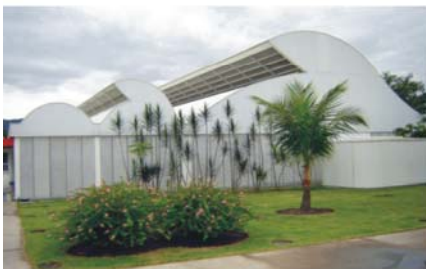
Fig.1.51 - vista dos fundos do hospital.
