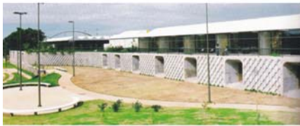
Fig.1.14 - tomadas de ar das galerias no arrimo.
