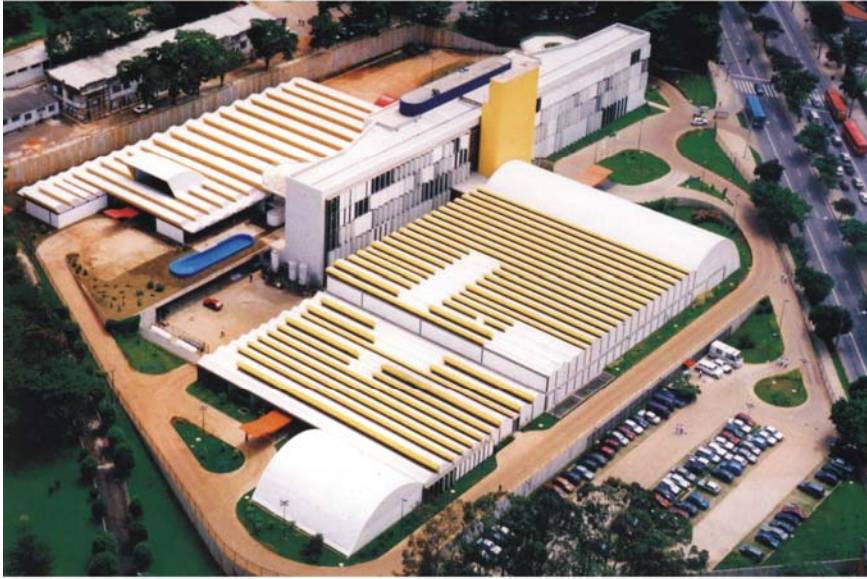
Fig.1.30 - vista aérea do hospital.
