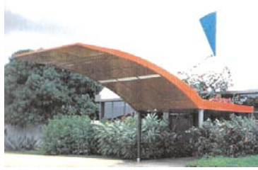
Figura 2.1. Marquise de acesso tipo C1 do Sarah Fortaleza.
