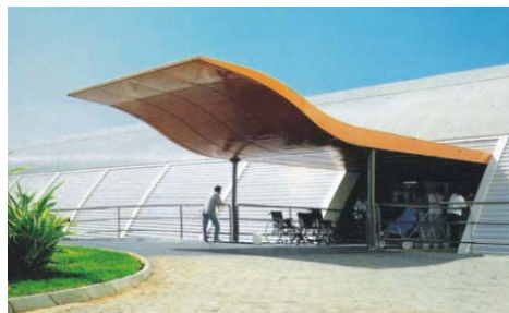
Figura 2.3. Marquise de acesso tipo D1 do Sarah Belo Horizonte.
