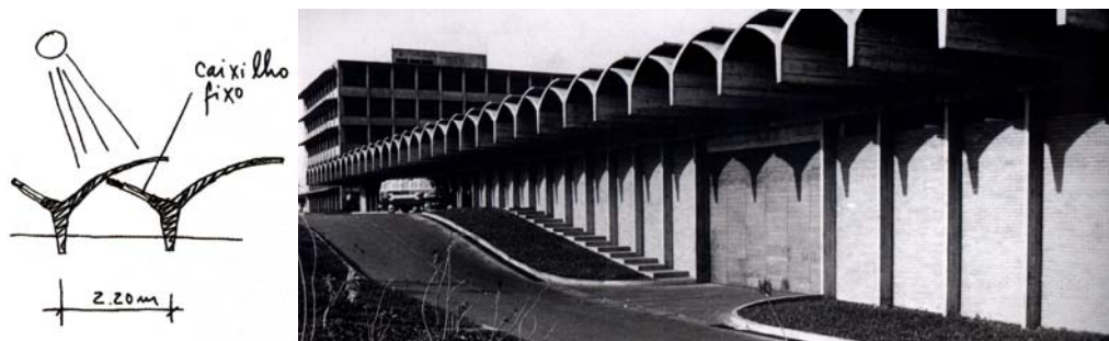
Figs. 1.2 e 1.3. Vigas- Shed e Fachada da Revendedora Disbrave, Brasília.
