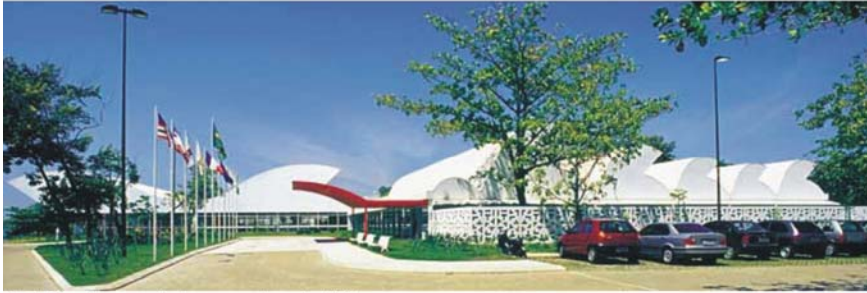
Fig.1.48 - vista a partir do acesso do ambulatório.
