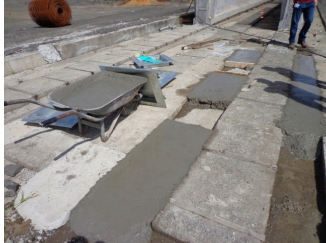
Figura 62: adaptação da pista de concreto para colocação das bases e moldes metálicos.
