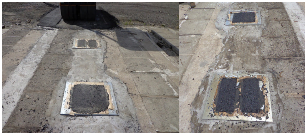
Figura 70: placas de mistura asfáltica compactadas.
