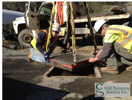
Figura 22: sistema utilizado para a retirada das placas de misturas asfálticas moldadas em campo, Universidade da Califórnia.
