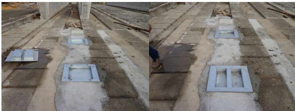
Figura 63: posicionamento das bases metálicas (a) na pista de concreto e dos moldes metálicos (b) no interior das bases.
