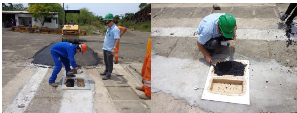
Figura 66: processo de preenchimento dos moldes metálicos com massa asfáltica.
