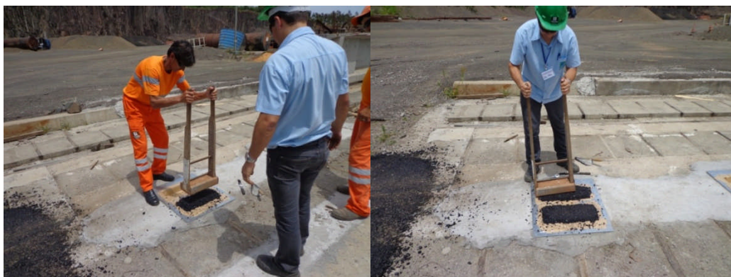
Figura 68: processo de pré-compactação da mistura asfáltica no interior dos moldes metálicos.
