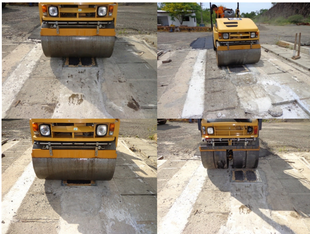
Figura 69: processo de compactação das placas de mistura asfáltica.
