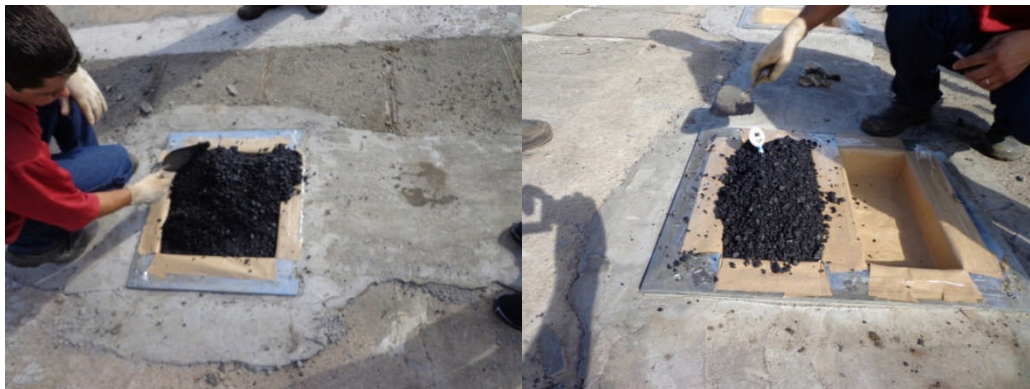
Figura 67: verificação da temperatura de compactação da mistura asfáltica.
