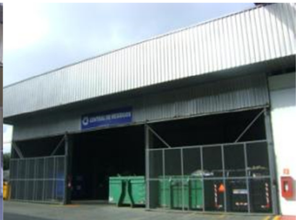
Foto 10. Central de Resíduos após a implementação da sistemática proposta, com os três contêineres para
