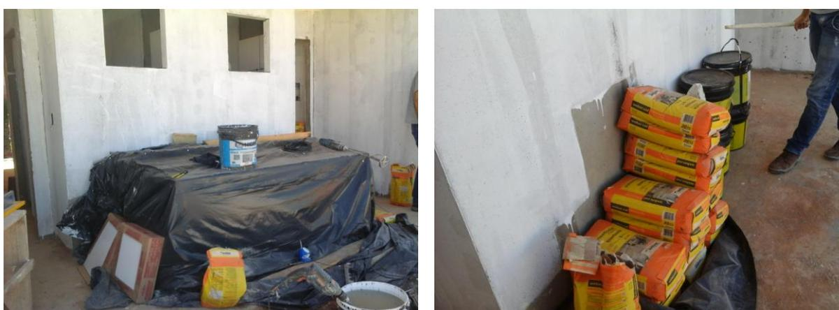
Figura 68: Armazenamento de placas de gesso (à esquerda) e sacos de cimento-cola (à direita) causando falta de terminalidade na aplicação do selador na parede
