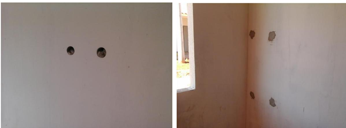
Figura 66: Regularização da parede executada antes do fechamento dos furos de extração de corpo-de-prova (à esquerda) e de fixação da linha de vida (à direita)
