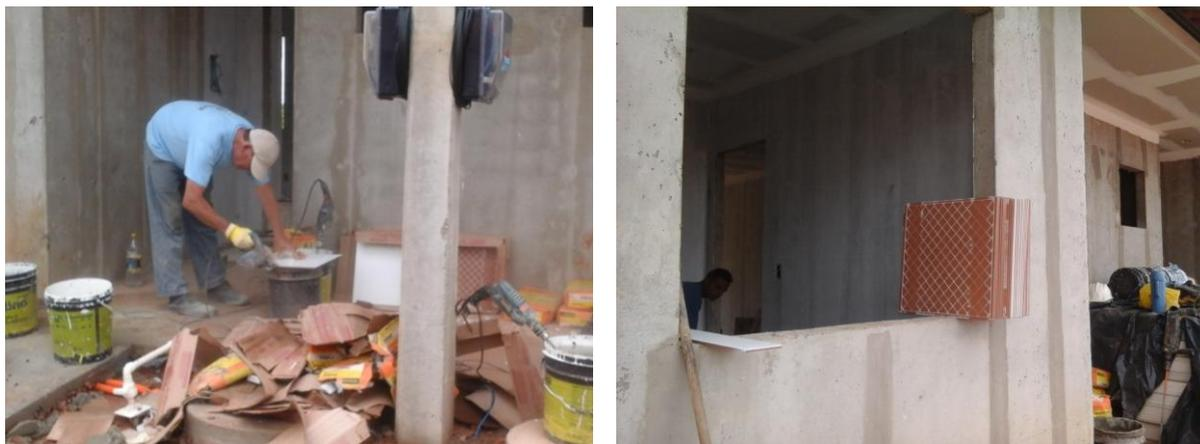
Figura 67: Ausência de uma bancada de trabalho para o serviço de revestimento cerâmico
