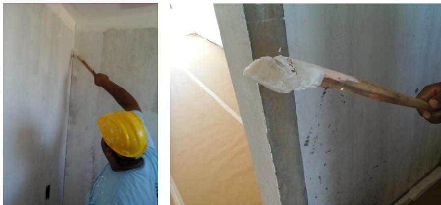
Figura 69: Improvisação de ferramenta para aplicar massa de regularização
