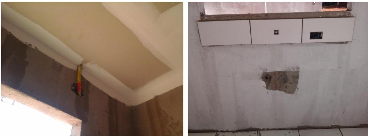
Figura 65: Execução de forro de gesso (à esquerda) e aplicação de selador (à direita) antes da finalização de reparos elétricos e hidráulicos
