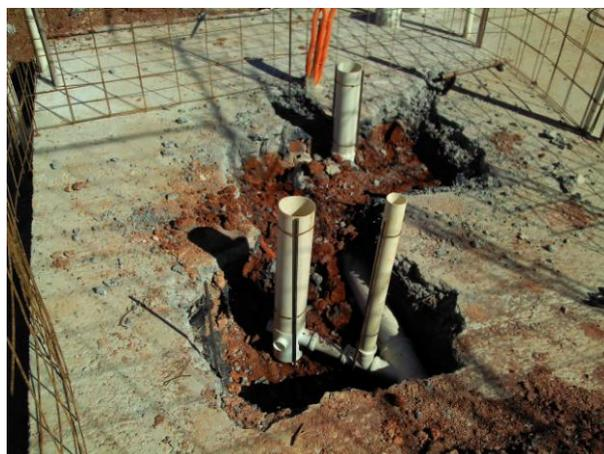
Figura 80: Retrabalho causado pela utilização de um kit de instalações hidráulicas incorreto
