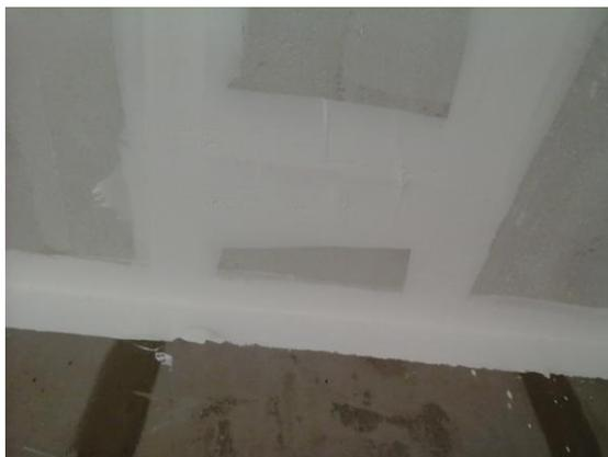
Figura 56: Falhas na execução no forro de gesso
