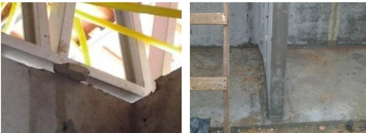
Figura 34: Perdas por *making-do* - pedra utilizada para nivelar a estrutura do telhado (à esquerda) e impacto gerado pelo uso de escoras inadequadas (à direita)
