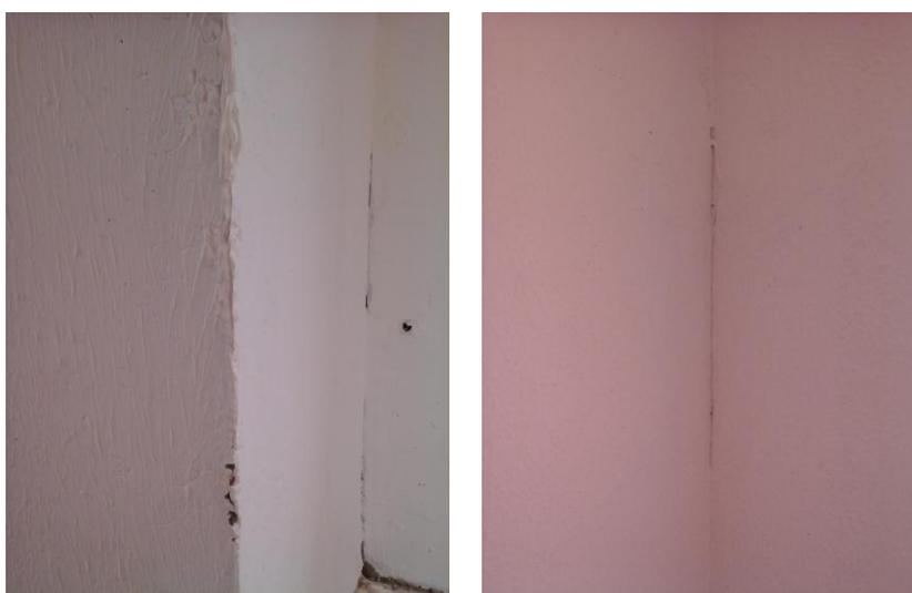
Figura 55: Falhas na regularização dos cantos das paredes
