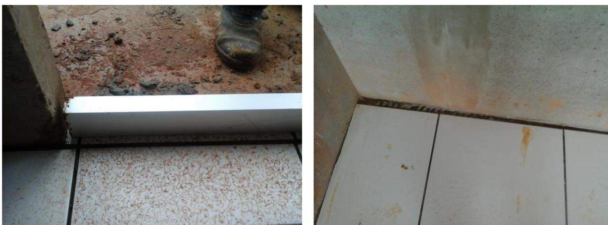
Figura 53: Propagação de defeito na tarefa precedente na execução da cerâmica
