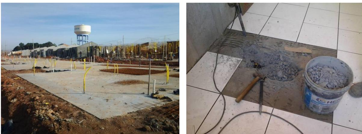
Figura 33: Perdas por *making-do* - conduítes inadequados para as instalações no radier
