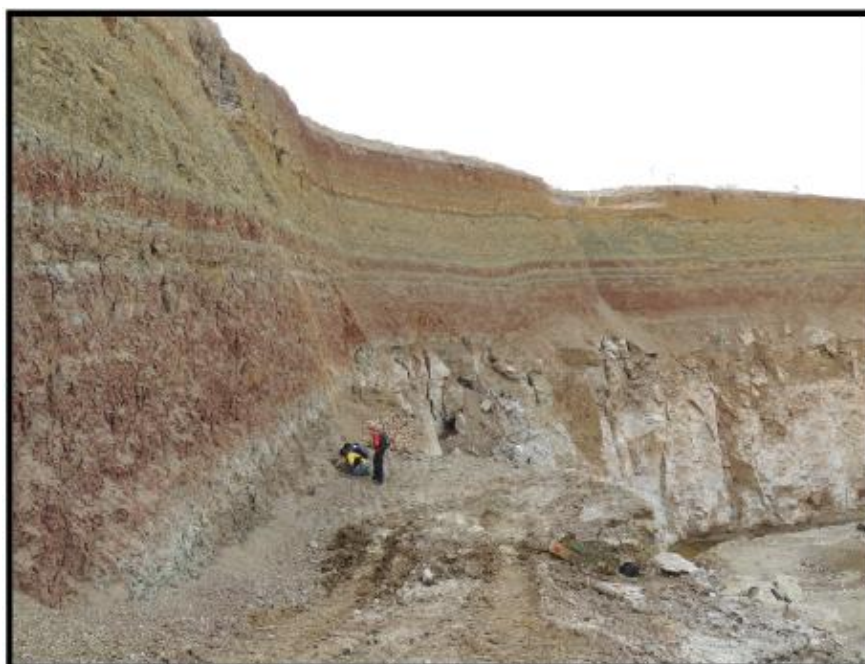
Figura 30. Sucessão de rochas siliciclásticas, carbonáticas e margas sobre a camada de sulfato com topo levemente irregular, perfil CH-37.
