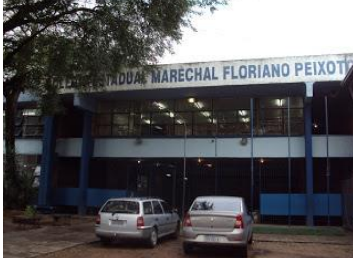
Figura 2 - Fachada da Escola Marechal Floriano Peixoto.
