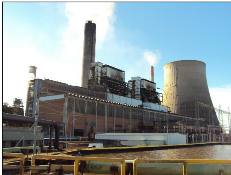
Figura 5: UTPM Candiota II, torre de resfriamento e chaminé de exaustão com respectivamente 133 e 150 metros de altura.
