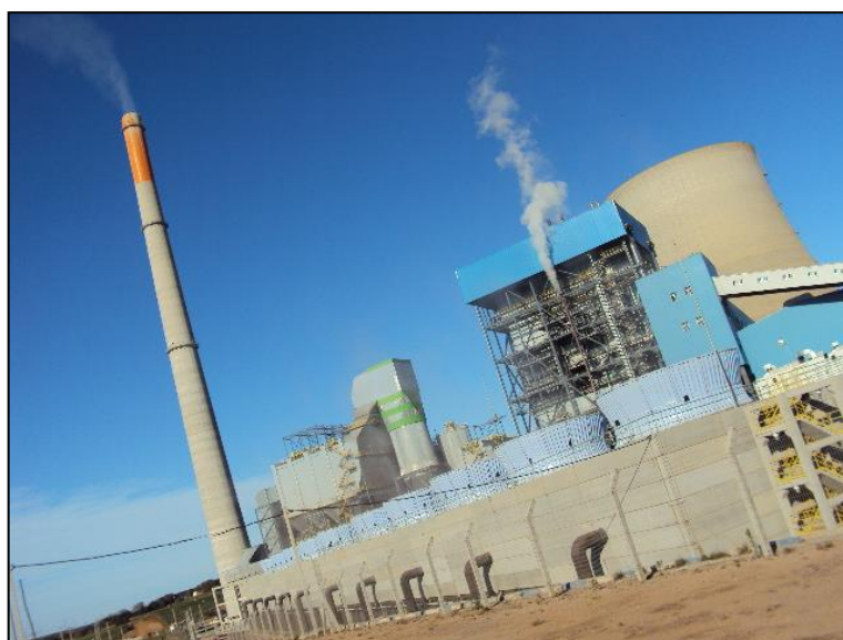
Figura 6: UTPM Candiota III fase C, chaminé de exaustão com respectivamente 200 metros de altura.
