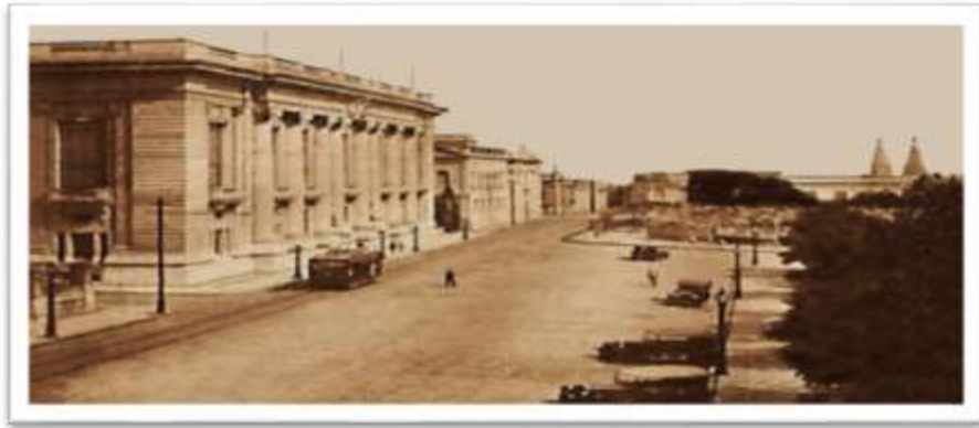
Fig. 17 - Demolição do Prédio da Companhia Hidráulica Porto-Alegrense. Porto Alegre (RS). [ca. 1928].
