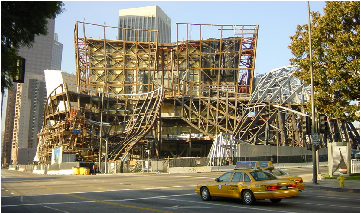
Figura 35 - Disney Concert Hall em construção. Frank Gehry - Fonte: http://www.arcspace.com / Kirsten Kiser
