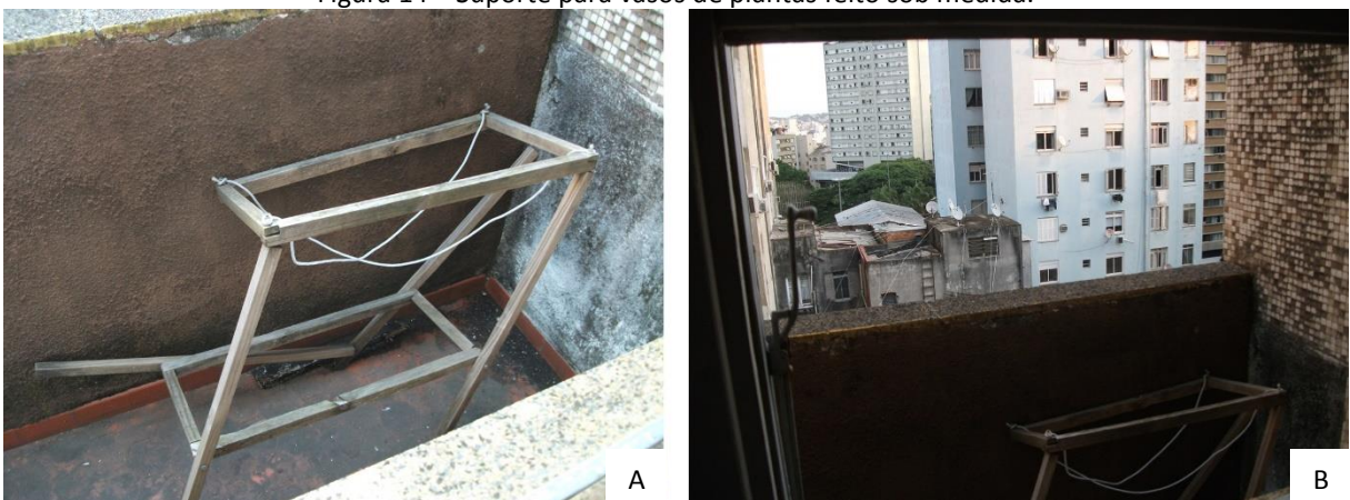
A: estrutura do suporte, parcialmente desmontada. B: vista para a sacada na qual o suporte era posto. Fonte: autor
