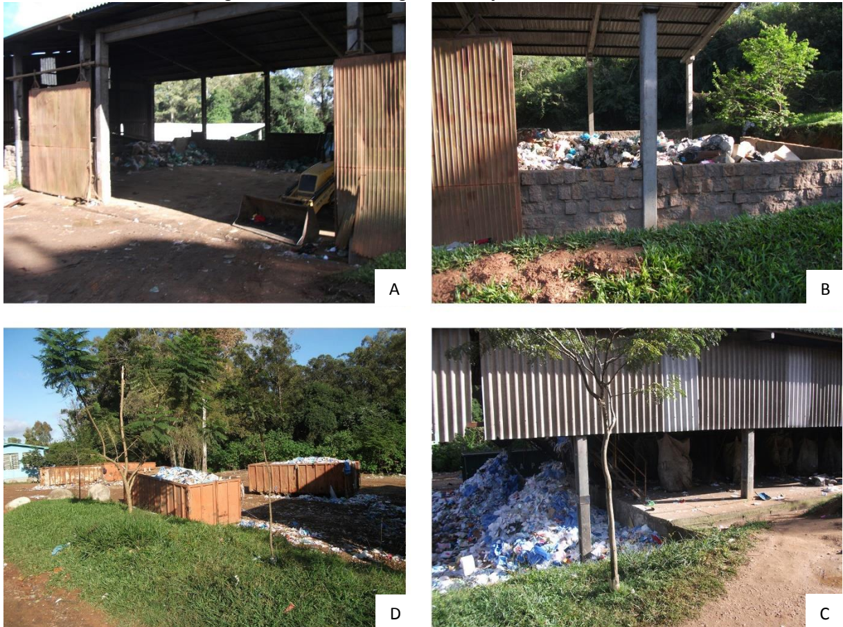
A e B: galpão de recebimento dos resíduos. C: galpão onde é realizada a triagem. D: contêineres com material para posterior venda já separado. Fonte: autor
