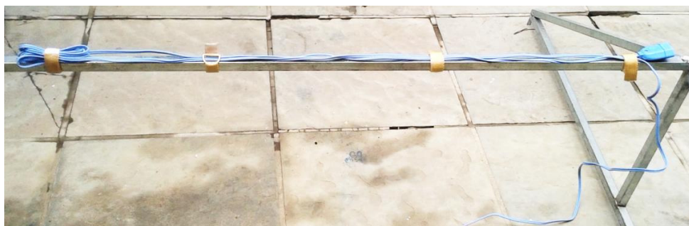
Figura 97: teste de aplicação do sistema de fixação de fios
