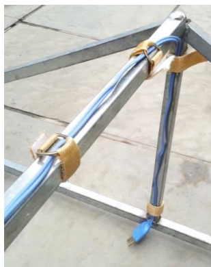
Figura 96: teste de aplicação do sistema de fixação de fios
