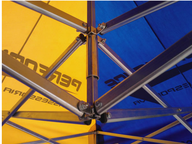
Figura 10: detalhe da união das peças da estrutura
