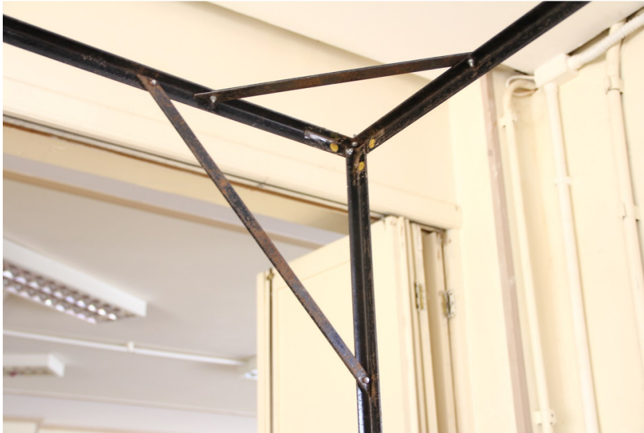
Figura 8: detalhe da fixação da estrutura
