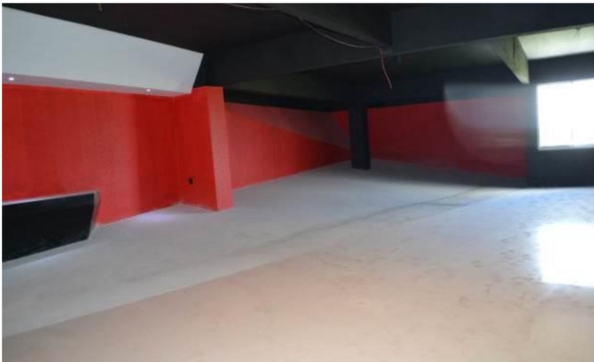
Figura 9: a laje do piso, próximo as paredes, é inclinada, própria para expor veículos. Foto do autor.
