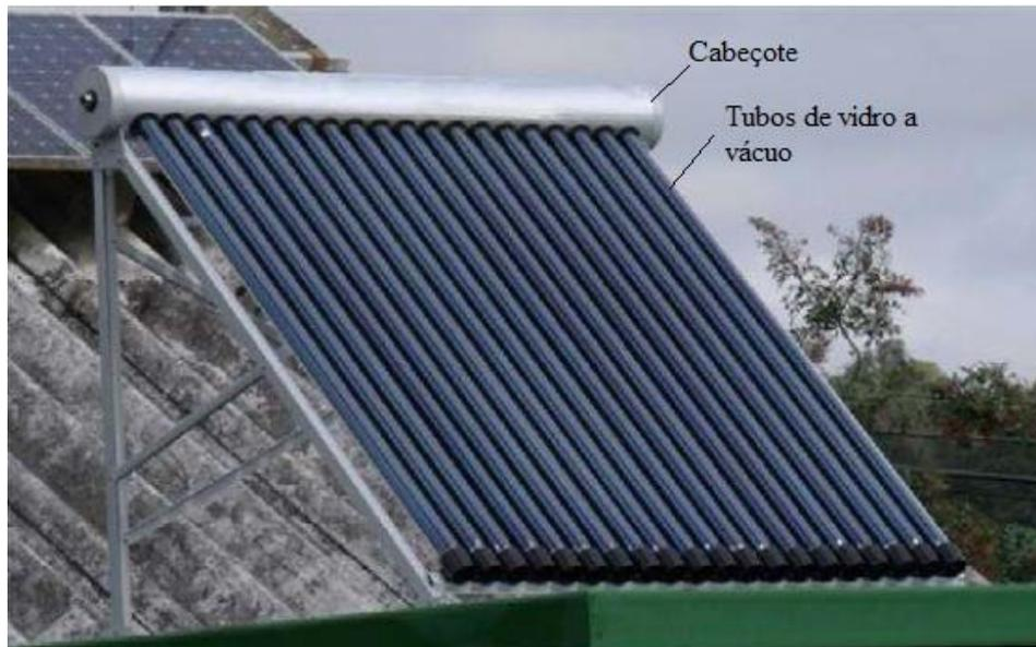
Figura 2.3 – Coletor solar de tubos de vidro a vácuo. Adaptado de Rosa (2012).
