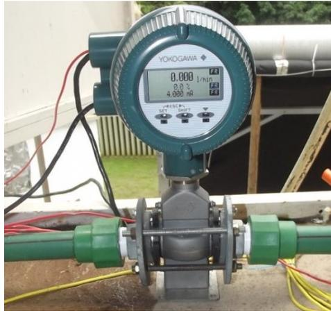
Figura 3.13 – Medidor de vazão do consumo de água.
