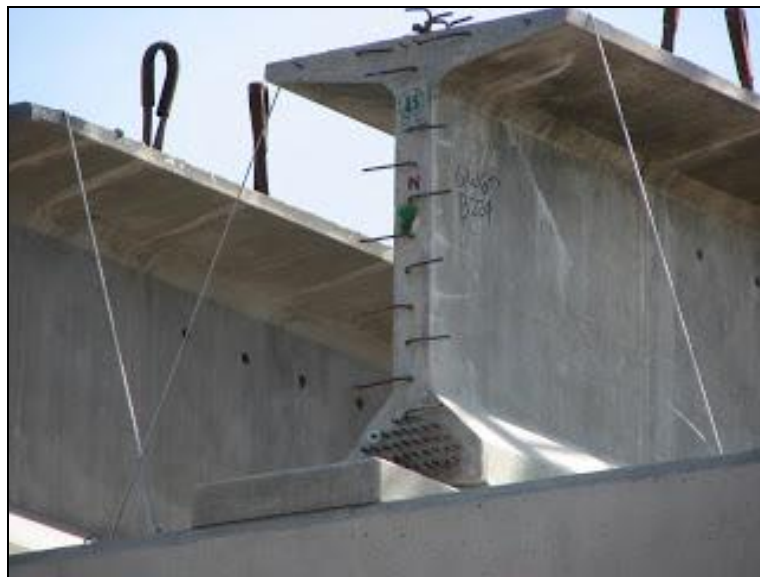
Figura 1.8: viga “T” protendida com aderência inicial.
