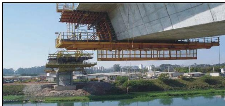
Figura 1.2: ponte protendida em balanços sucessivos (RUDLOFF, 2006).
