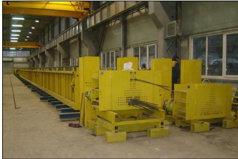
Figura 1.4: pista de protensão (INMET KONSTRUKCJE, 2014).
