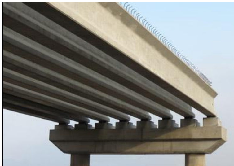
Figura 1.3: utilização de vigas protendidas para o apoio de tabuleiro em pontes (OBERBETON, 2014).
