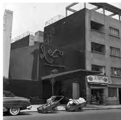
Fig. 70 | Imagem de uma das intervenções realizadas na fachada do edifício do Museu Experimental El Eco . A data não foi localizada.
