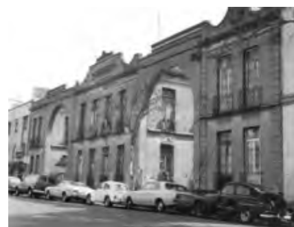
Fig. 44 | Colonia de Los Arquitectos - Privada Serapio Rendón 40-42
