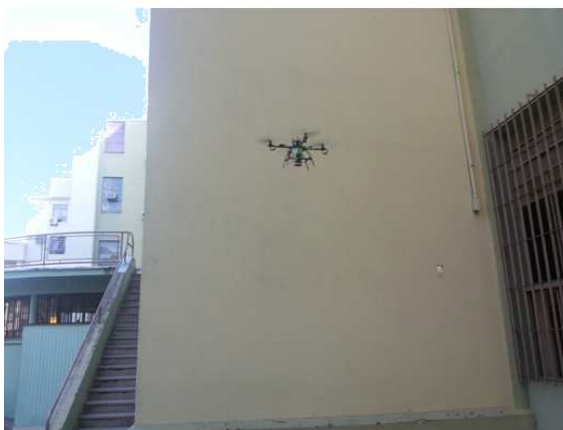
Captura da Imagem Utilizando VANT em uma Fachada de Argamassa
