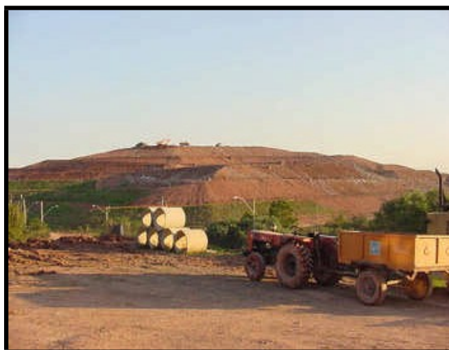
Figura 35 - Vista panorâmica do aterro sanitário Santa Tecla. Data de 31/07/2003.
